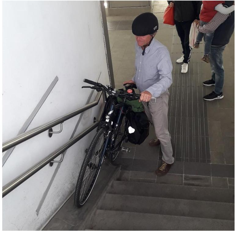
*Soluzione efficace nella stazione ferroviaria RFI di Torino Lingotto. La bicicletta può essere mantenuta in posizione quasi verticale anche con le borse laterali. La superficie ruvida impedisce alla bicicletta di scivolare.*
