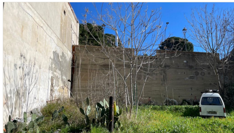
Muro di contenimento in c.a. a valle di Via Vespucci con i fori dei drenaggi suborizzontali (Provincia di Matera)
