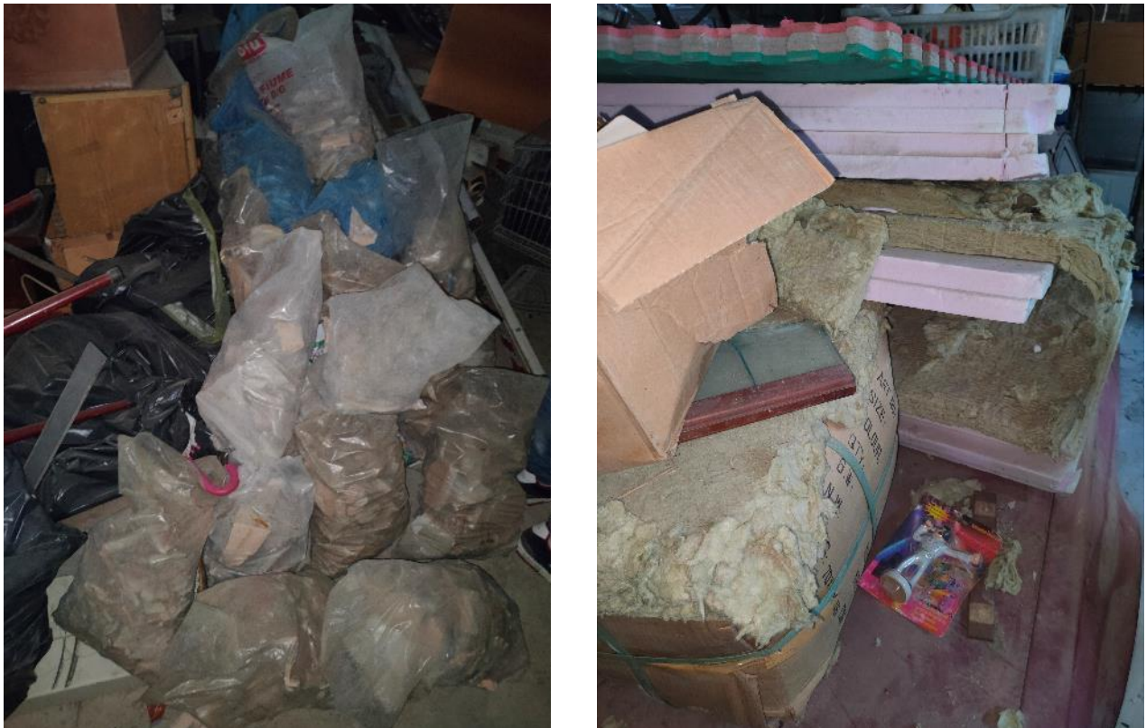
Foto 2 Rifiuti derivanti da operazioni di costruzione e demolizione; da sinistra miscugli di cemento e materiali isolanti
