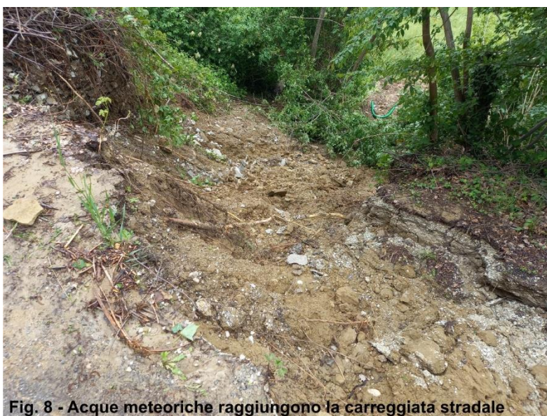
Fig. 7 - Acque meteoriche raggiungono la carreggiata stradale
