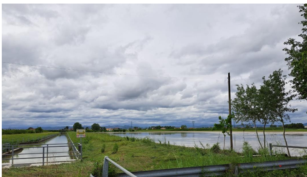
Figura 4: Area del CER interessata dagli allagamenti
