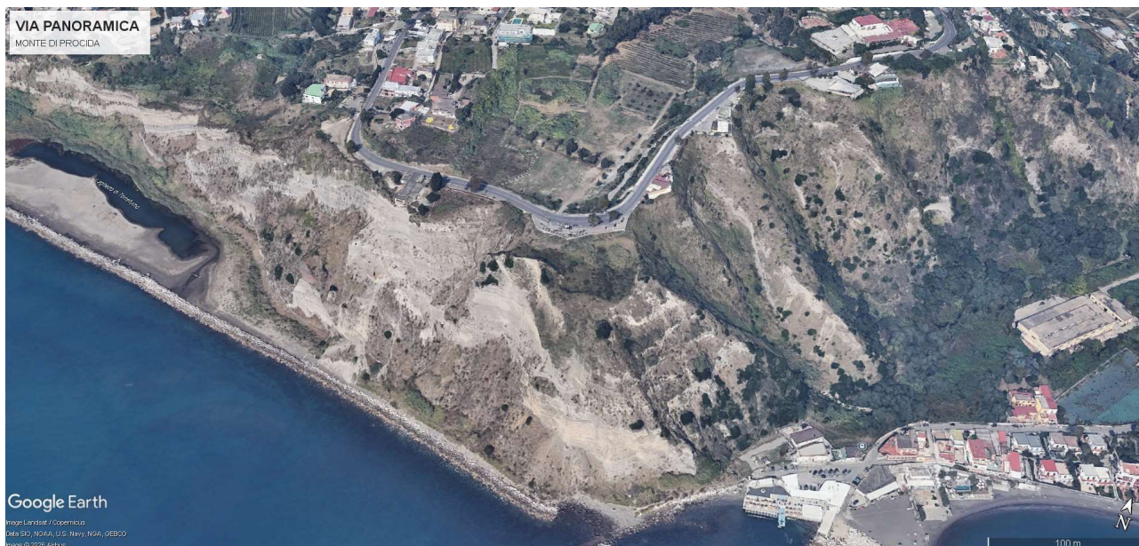
Via Panoramica – Monte di Procida – Tratto incombente su costone a rischio
