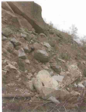
Crollo sul sentiero per il Gran Piano
