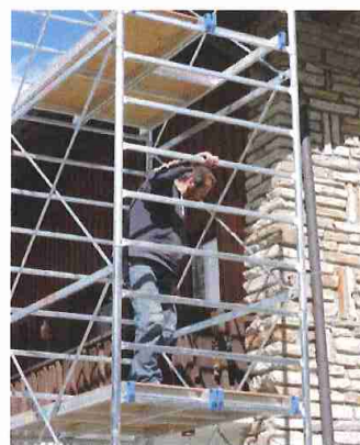
Lavori di manutenzione ordinaria eseguiti dal personale interno sulla foresteria di Lillaz
