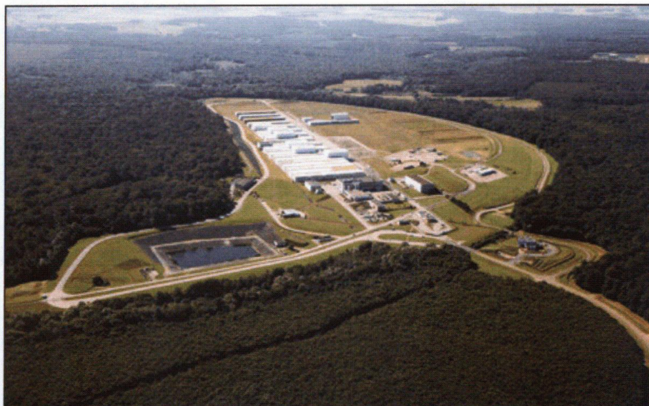
Fig. 4 – Vista d'insieme del deposito per rifiuti a bassa e media attività de l'Aube
