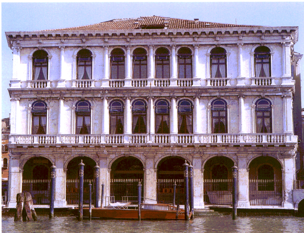
Venezia, Palazzo Dolfin, poi Manin, costruito su progetto di Jacopo Sansovino intorno alla metà del Cinquecento e affacciato sul Canal Grande, sede della Filiale della Banca d'Italia.
