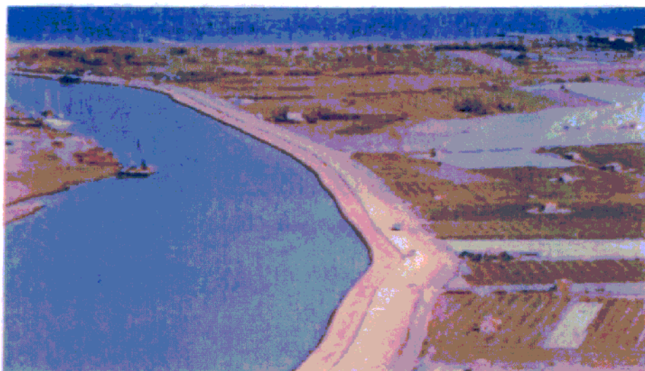
Veduta aerea dei lavori relativi al 1° stralcio da SS 309 Roma alla foce del fiume Brenta: lavori di ringrosso dell'argine e strada provvisoria
