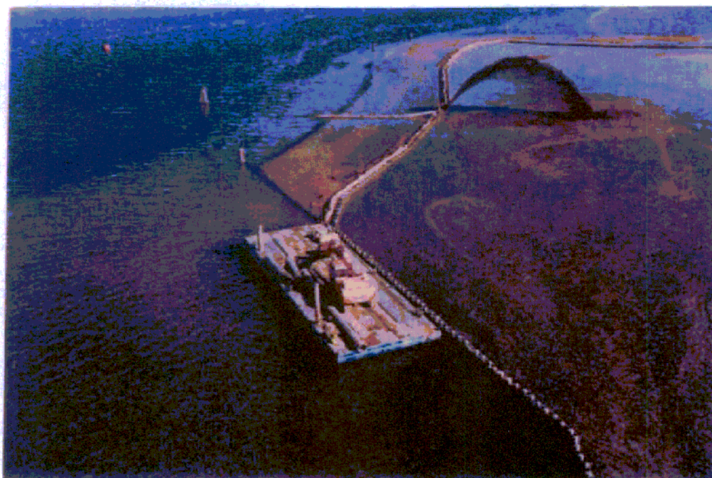
Realizzazione delle Barene in zona Bastia
