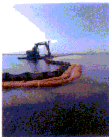
Confermazione della barena Risolo Vecchia, pali rete e burghie
