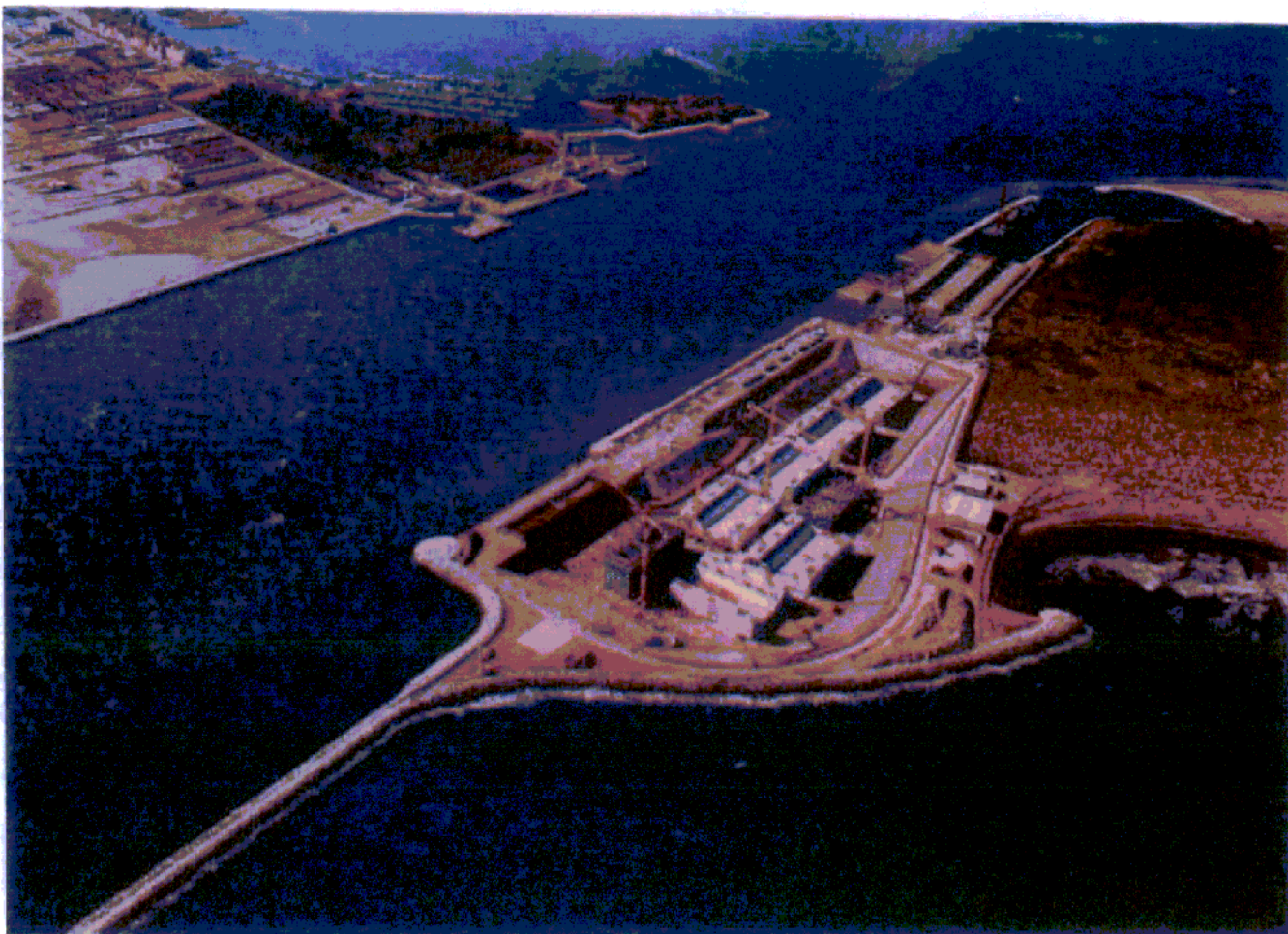
Bocca di Chioggia: il bacino del porto rifugio lato mare. Il bacino è stato messo all'asciutto e utilizzato come "rura" per la prefabbricazione dei cassoni di alloggiamento delle paratoie della barriera di Chioggia
