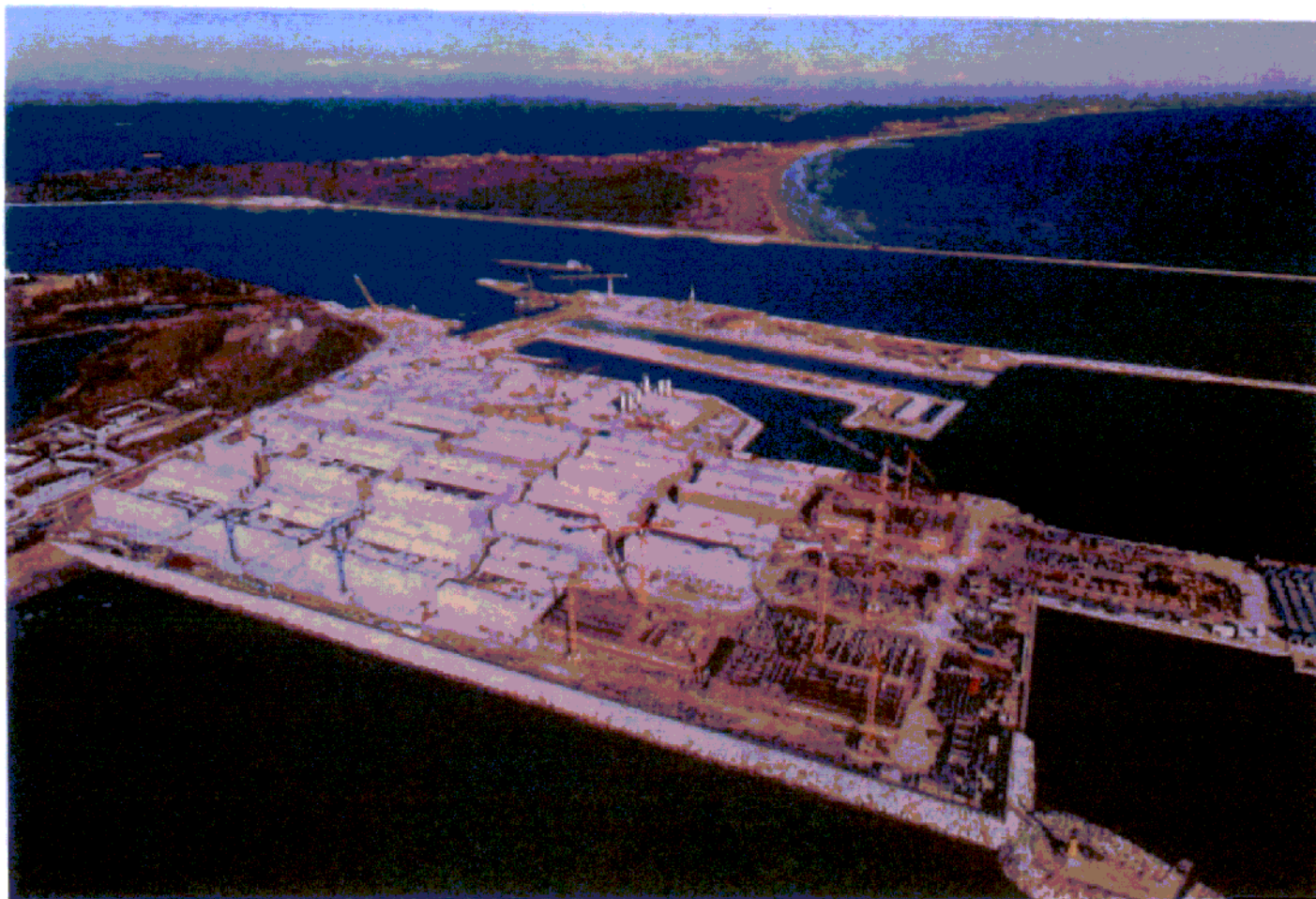
Bocca di Malamocco: veduta d'insieme del rilevato provvisorio sul quale sono in corso le lavorazioni di prefabbricazione dei 7 + 7 cassoni di soglia (già completati) e dei 2 • 2 cassoni di spalla (lavorazioni in corso) per le barriere di Malamocco e di San Nicolò
