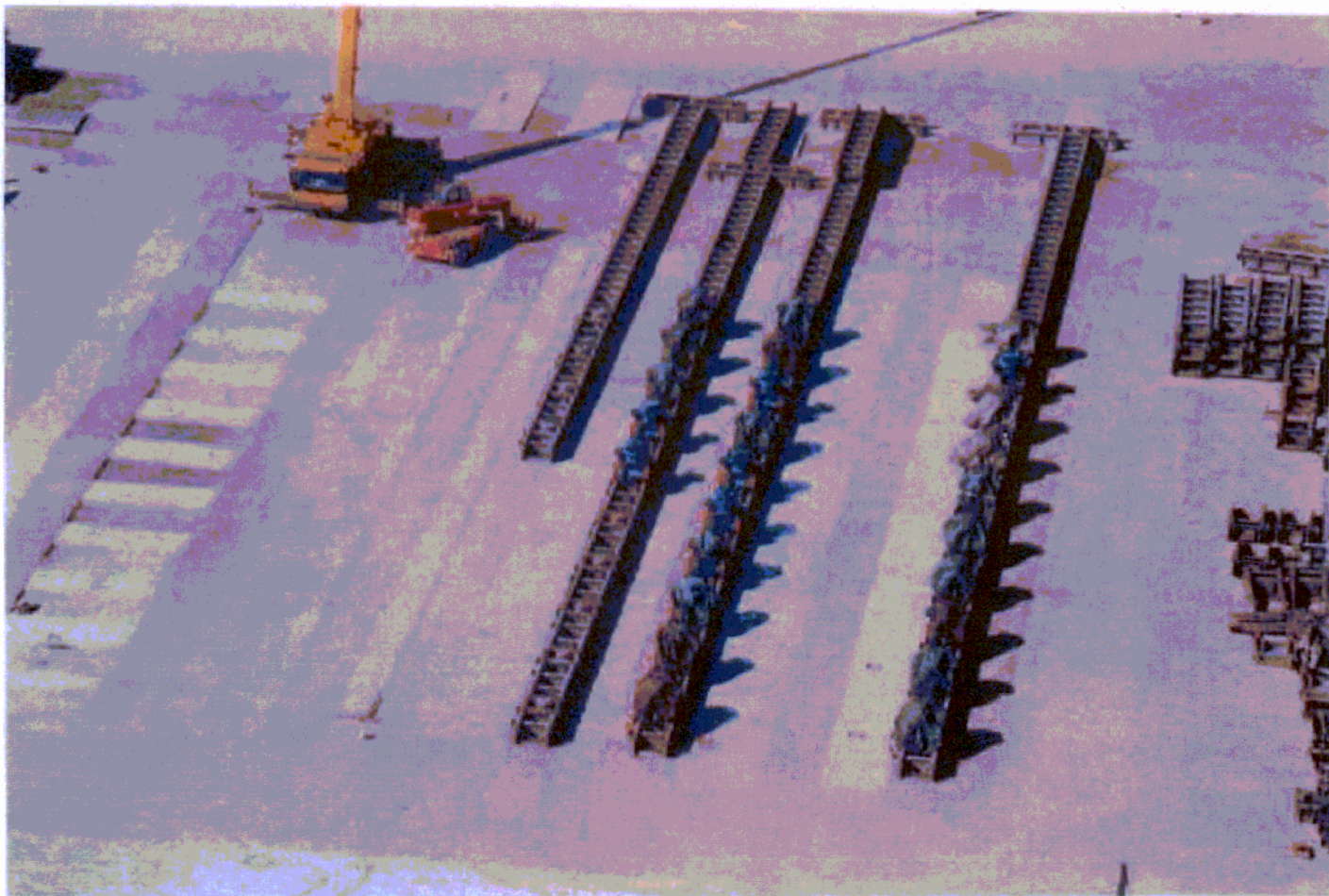
Bocca di Malamocco: particolare del sistema di carrelli e rotaie, mediante il quale verranno movimentati, sul rilevato provvisorio, i cassoni completati per essere varati col Syncrolift
