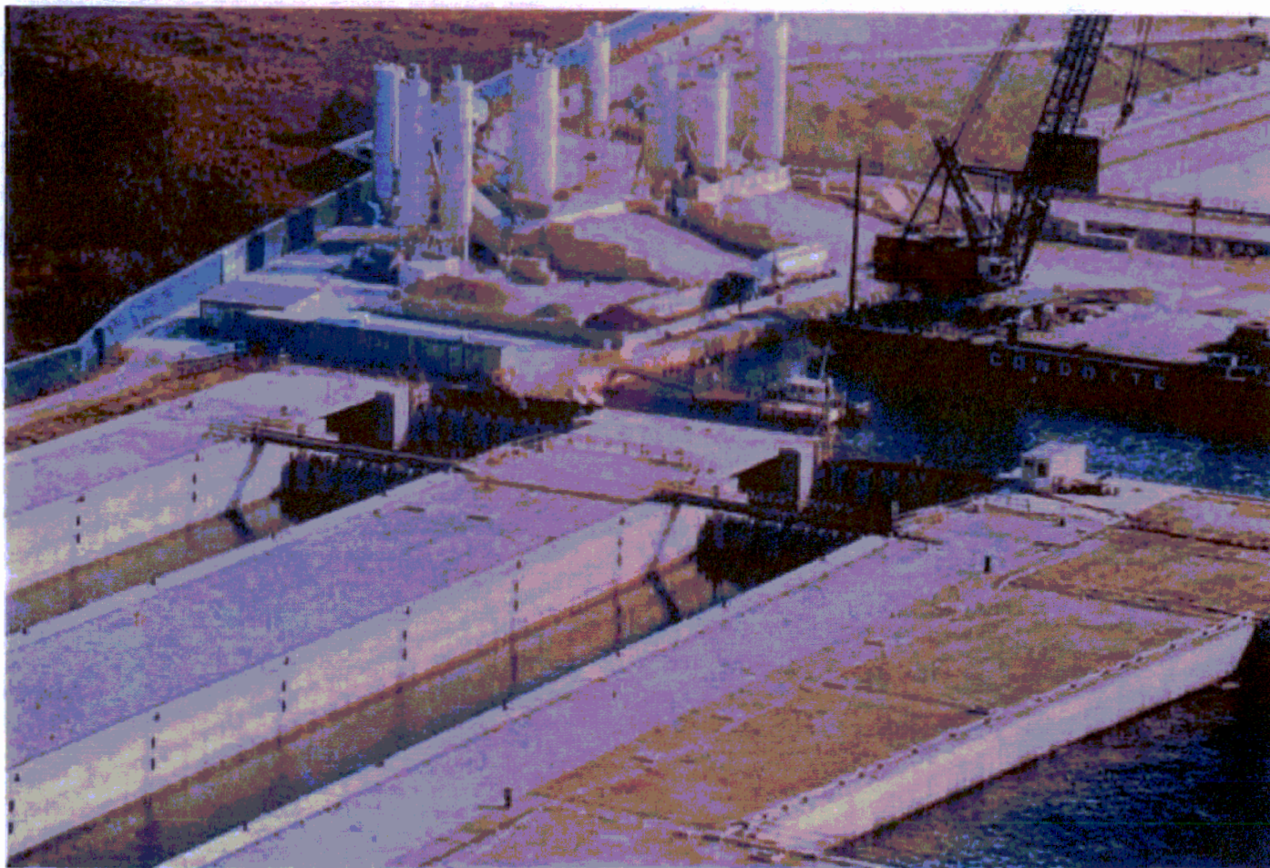
Bocca di Chioggia: particolare delle strutture che ospiteranno le porte delle due conche di navigazione per pescherecci
