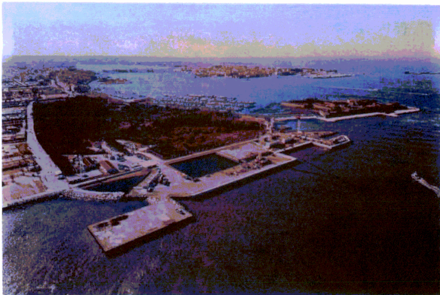
Bocca di Chioggia: lavorazioni per la realizzazione della spalla sud della barriera di Chioggia, ove verranno realizzati anche gli edifici che ospiteranno gli impianti
