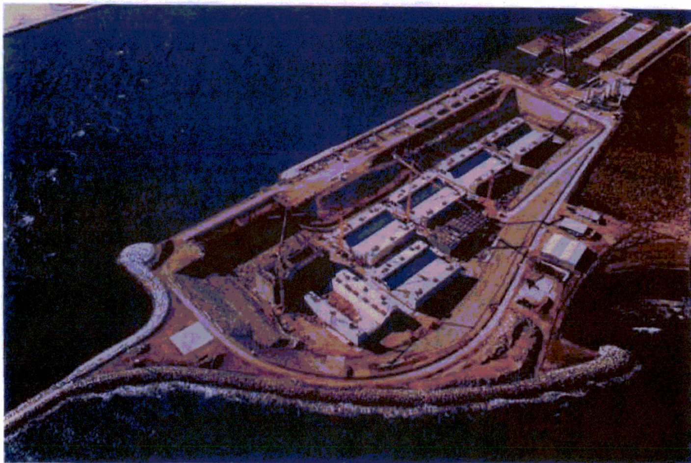
Bocca di Chioggia: il bacino del porto rifugio lato mare con, già completati, i 6 cassoni di soglia che ospiteranno le 18 paratoie. In fase di realizzazione i 2 cassoni di spalla
