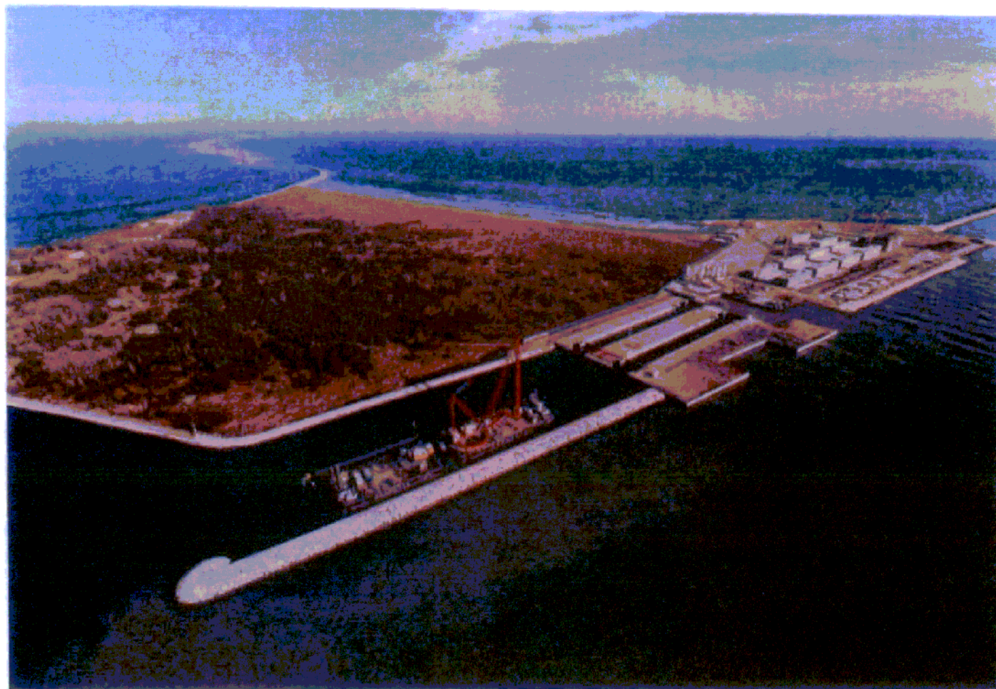
Bocca di Chioggia: in primo piano le due conche di navigazione per pescherecci. In alto il bacino lato mare messo all'asciutto e utilizzato come tura per la costruzione dei cassoni di soglia e di spalla
