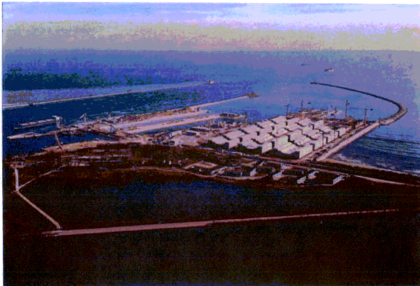
Bocca di Malamocco: veduta d'insieme del rilevato provvisorio sul quale sono in corso le lavorazioni di prefabbricazione dei 7 + 7 cassoni di soglia e dei 2 + 2 cassoni di spalla per le barriere di Malamocco e di San Nicolò. In primo piano, le strutture abitative provvisorie a supporto del cantiere
