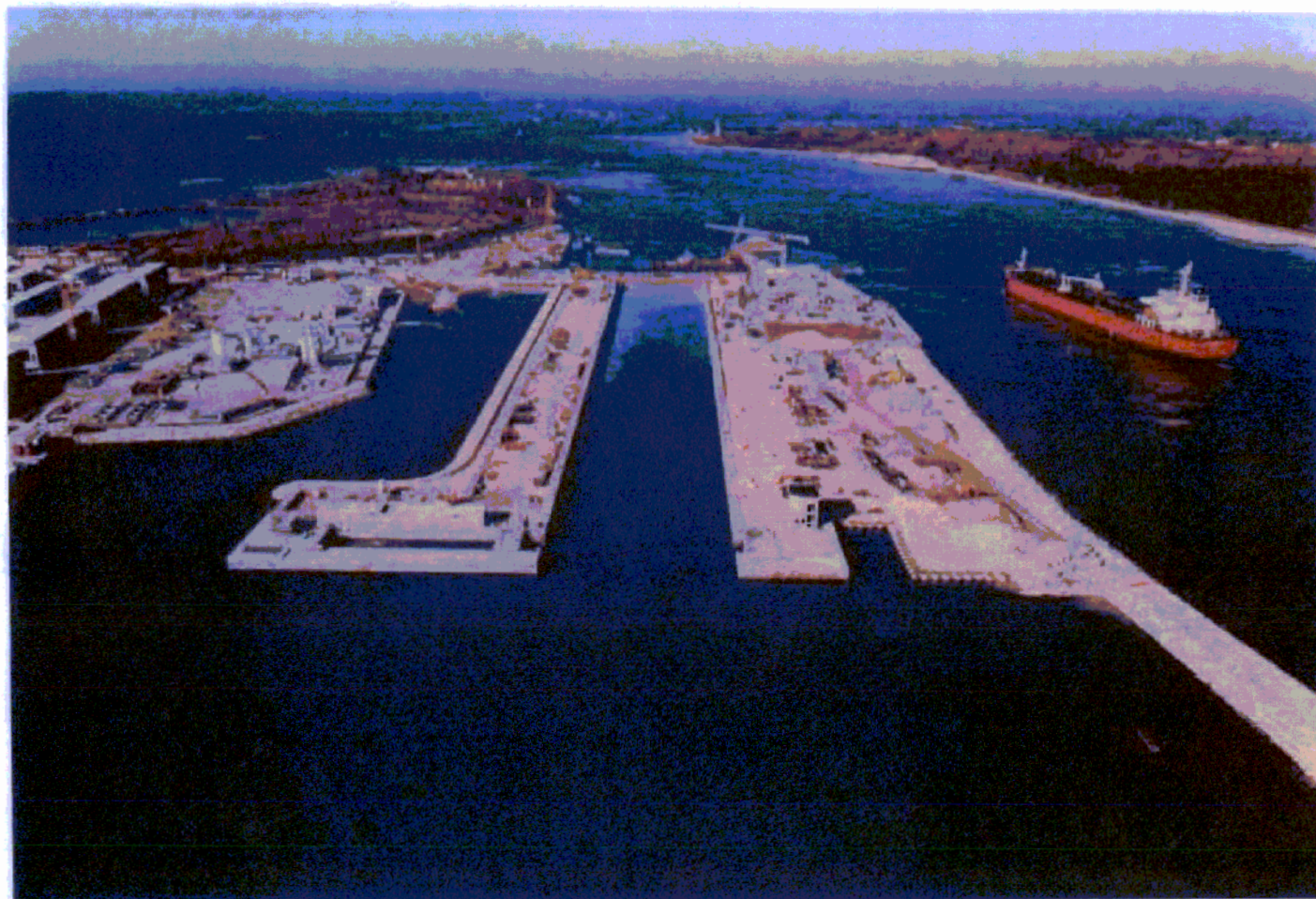
Bocca di Malamocco: veduta d'insieme della conca di navigazione per grandi navi a Malamocco. In primo piano, le strutture della porta lato mare
