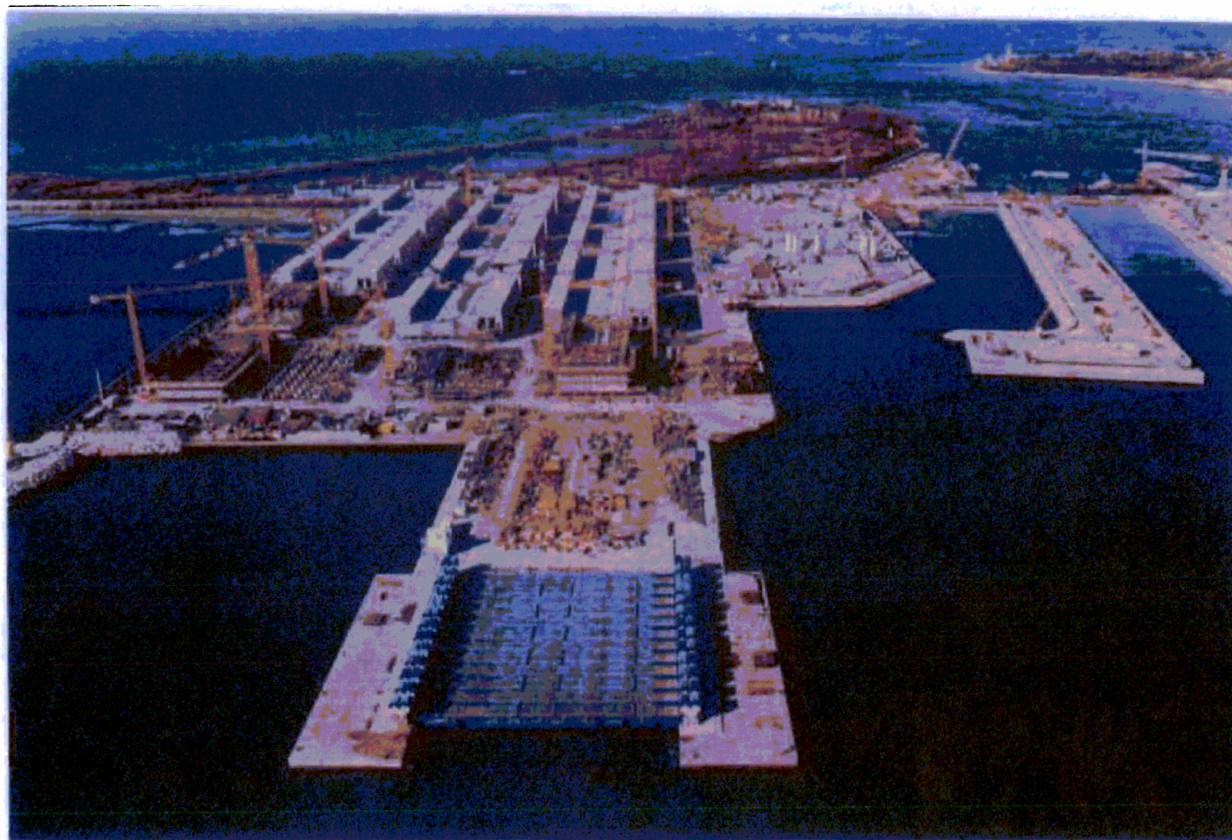
Bocca di Malamocco: veduta d'insieme del rilevato provvisorio sul quale sono eseguite le lavorazioni di prefabbricazione dei cassoni di soglia e di spalla per le barriere di Malamocco e di San Nicolò. In primo piano, il sistema Syncrolift per il varo dei cassoni. Sulla destra, la conca di navigazione per grandi navi
