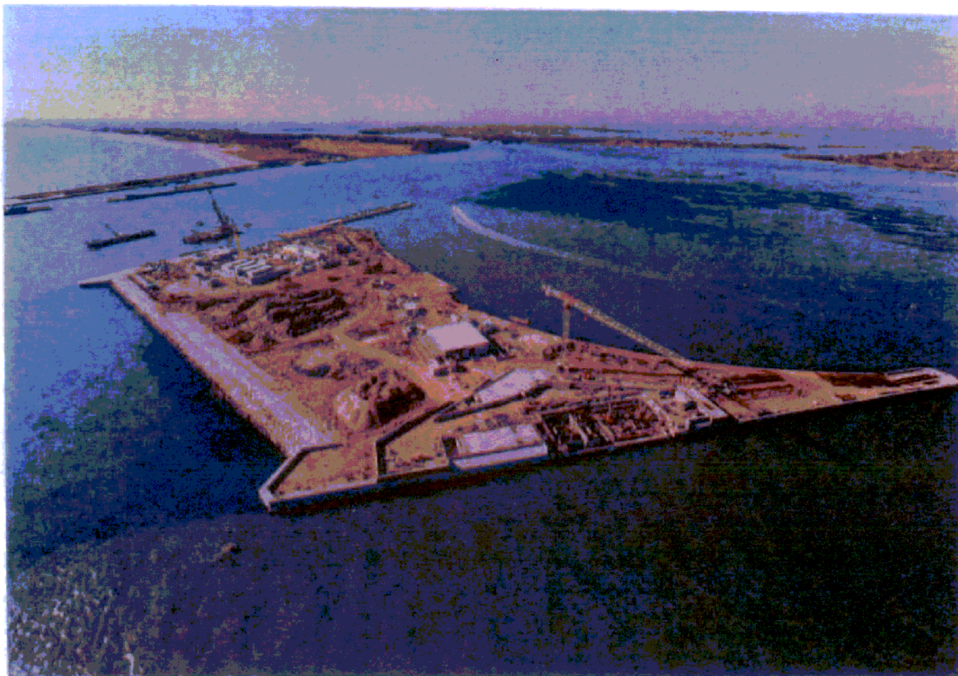
Bocca di Lido: in primo piano, le strutture di spalla ovest della barriera di Treporti sull' "isola nuova" con gli edifici di servizio, a loro volta collegati con gli edifici della spalla nord di S. Nicolò mediante il tunnel sotterraneo
