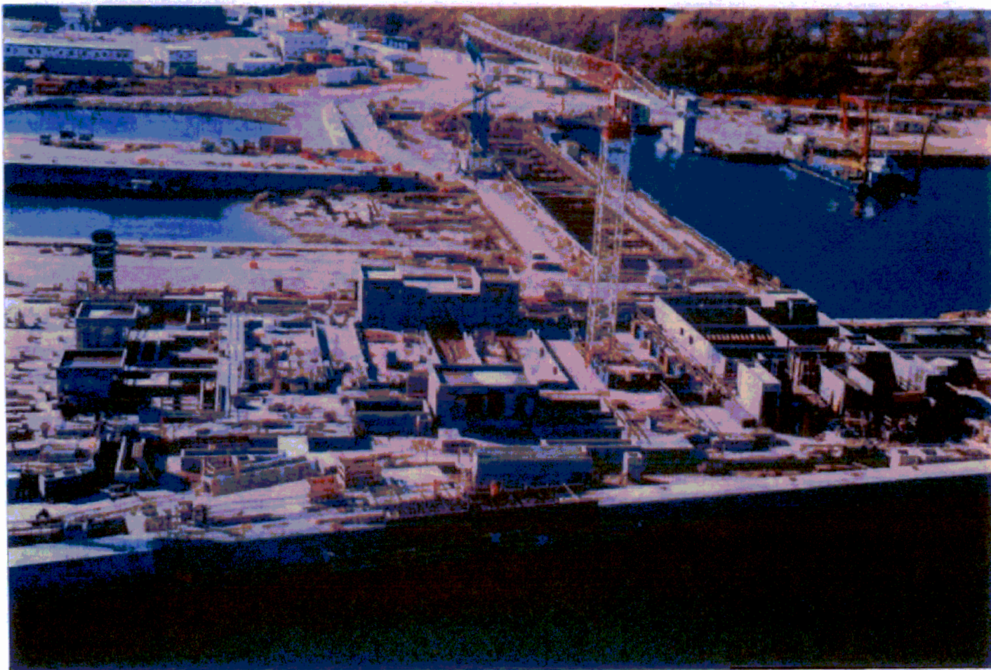
Bocca di Malamocco: particolare delle lavorazioni per la realizzazione degli edifici tecnici che ospiteranno strumentazione e impianti per il funzionamento della conca e della barriera
