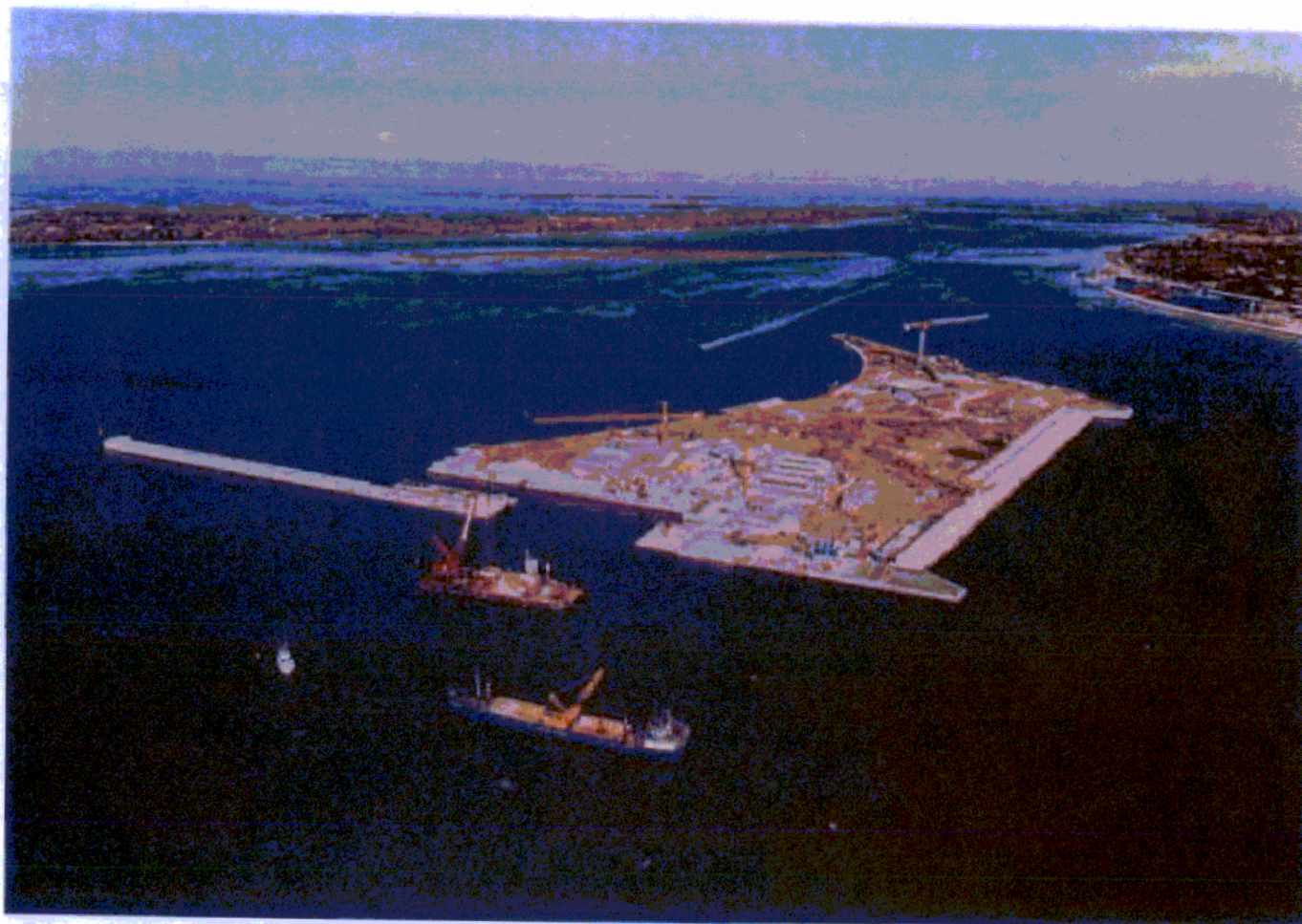
Bocca di Lido: veduta d'insieme dell'"isola nuova" della bocca di porto del Lido. In primo piano, la spalla nord della barriera di S. Nicolò
