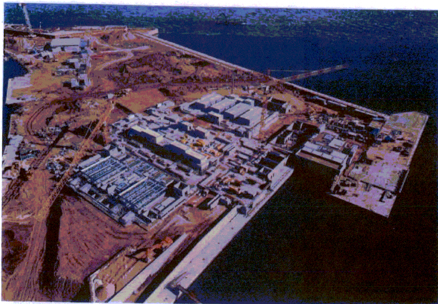
Bocca di Lido: strutture di spalla nord di S. Nicolò sull' "isola nuova" con gli edifici tecnici che ospiteranno gli impianti
