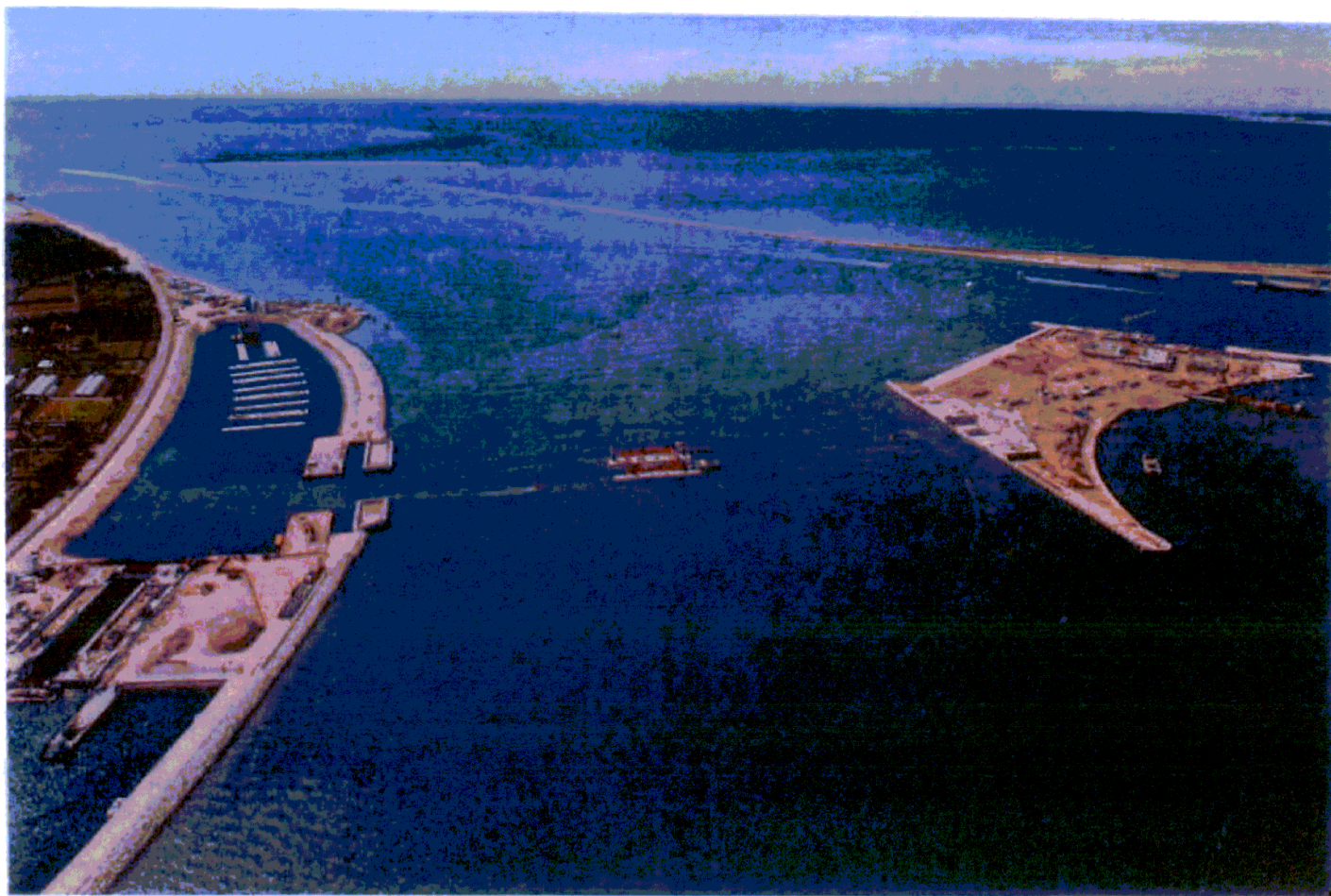
Bocca di Lido - Treporti: particolare delle attività di varo di un cassone di soglia. Nel bacino lato mare allagato, gli altri cassoni sono in attesa delle operazioni di varo. Al 30/09/12, tutti i cassoni di Treporti sono stati varati e posizionati all'interno della relativa trincea
