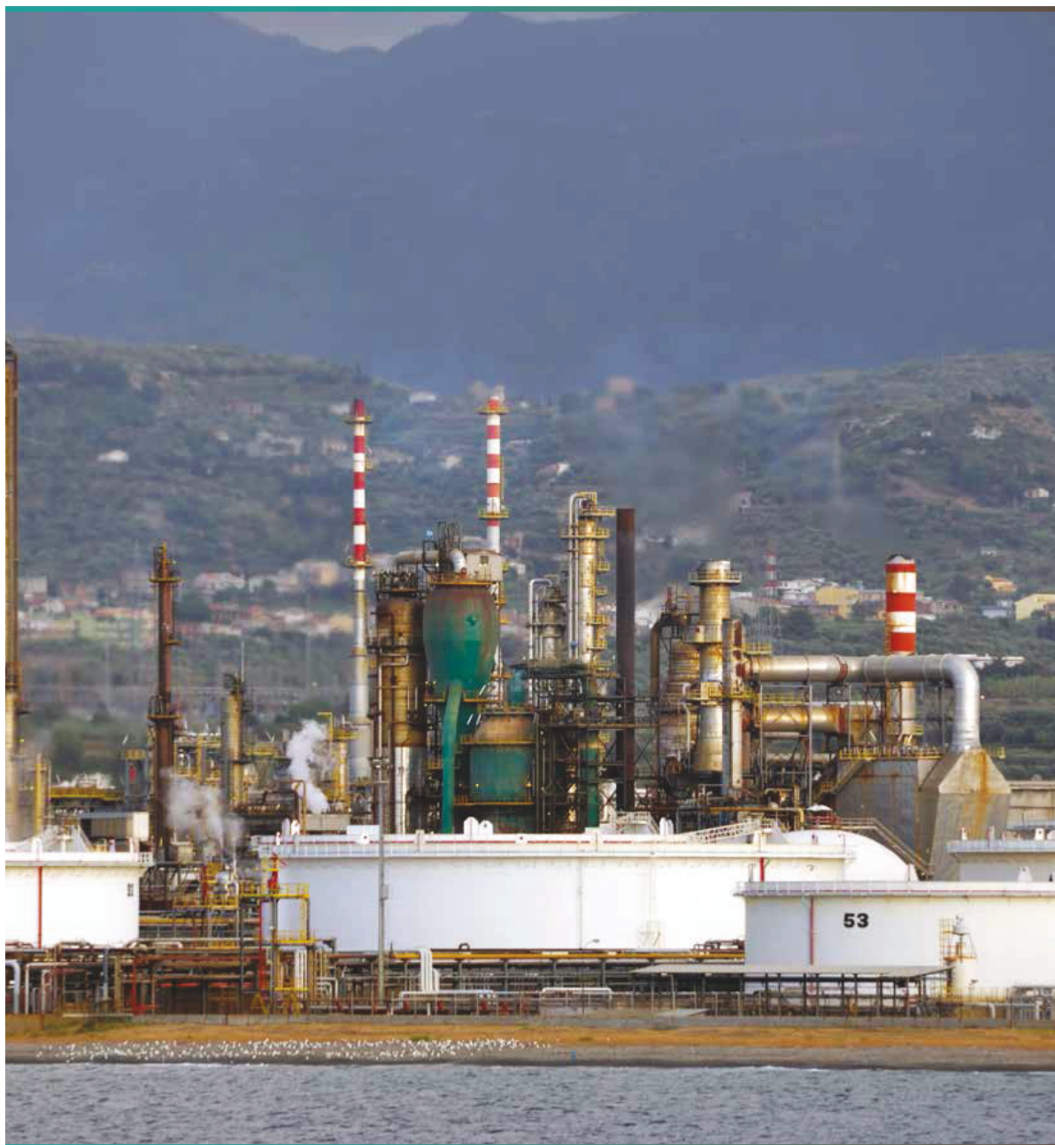
Foto 10.20 Impianti industriali Fonte MATTM Luca Grassi
