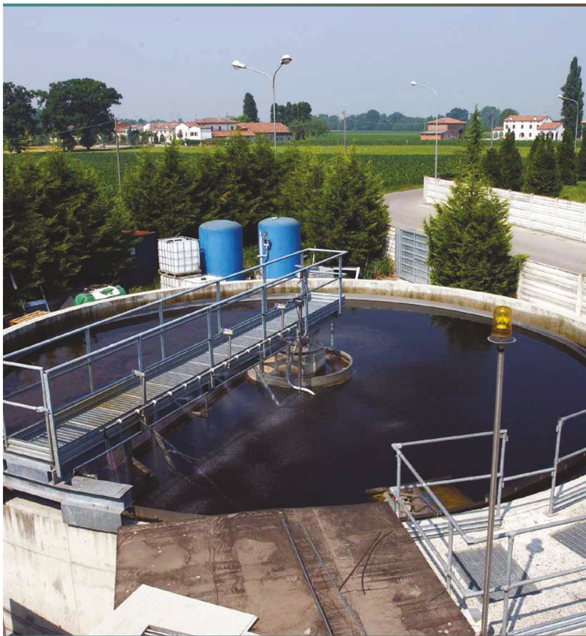
Foto 5.12 Sedimentatore con carroponte Fonte ISPRA Paolo Orlandi
