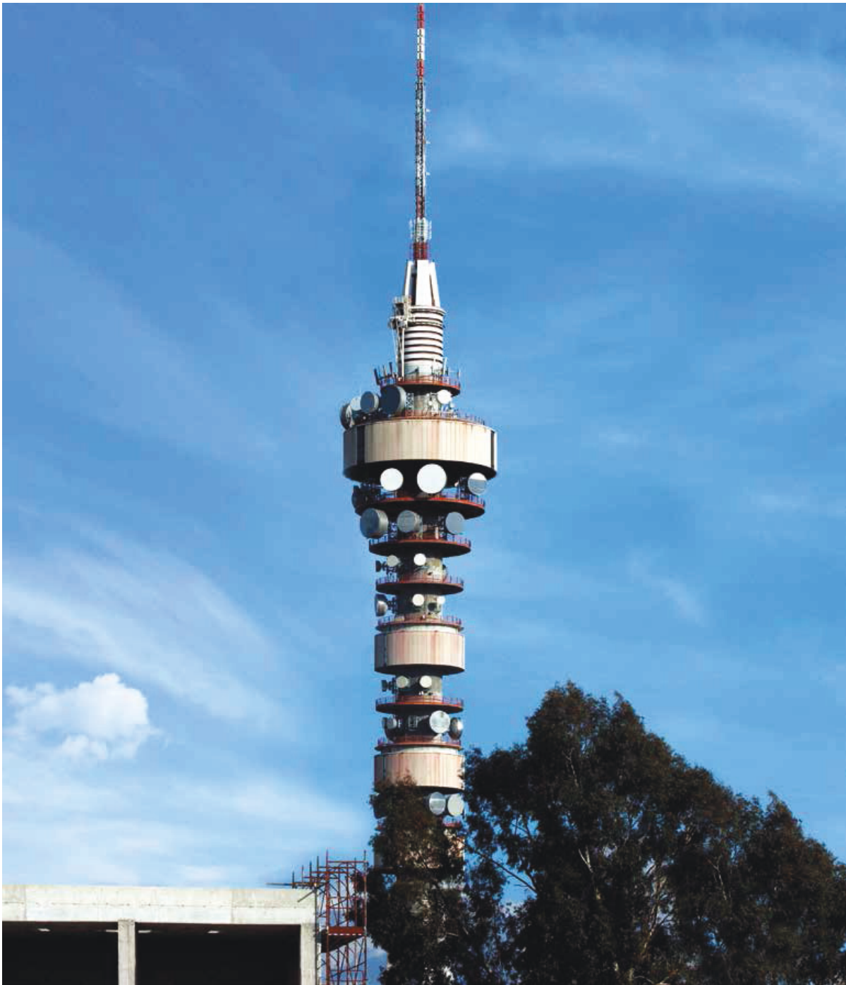
Foto 3.07 Antenna RTV Fonte ISPRA Paolo Orlandi
