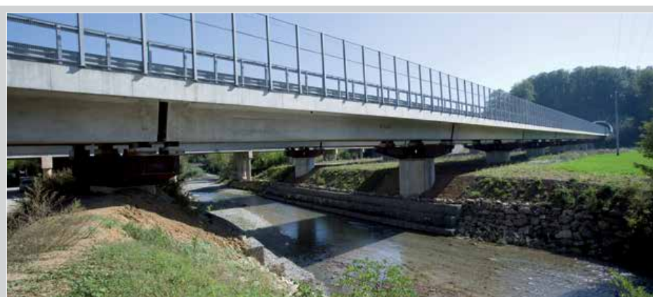
■ Autostrada A3 Salerno-Reggio Calabria - Viadotto Calore
