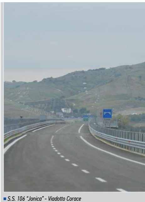
■ S.S. 106 "Jonica" - Viadotto Corace
