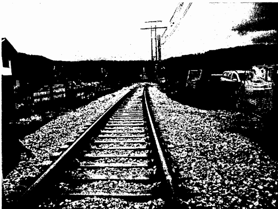
Lavori di rimozione dei detriti dalla sede ferroviaria.
