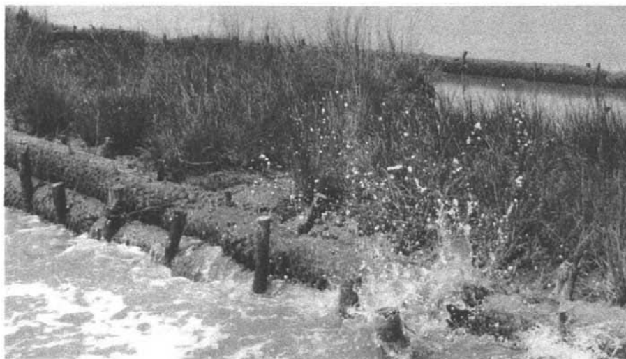
Protezione barene mediante buzzoni
