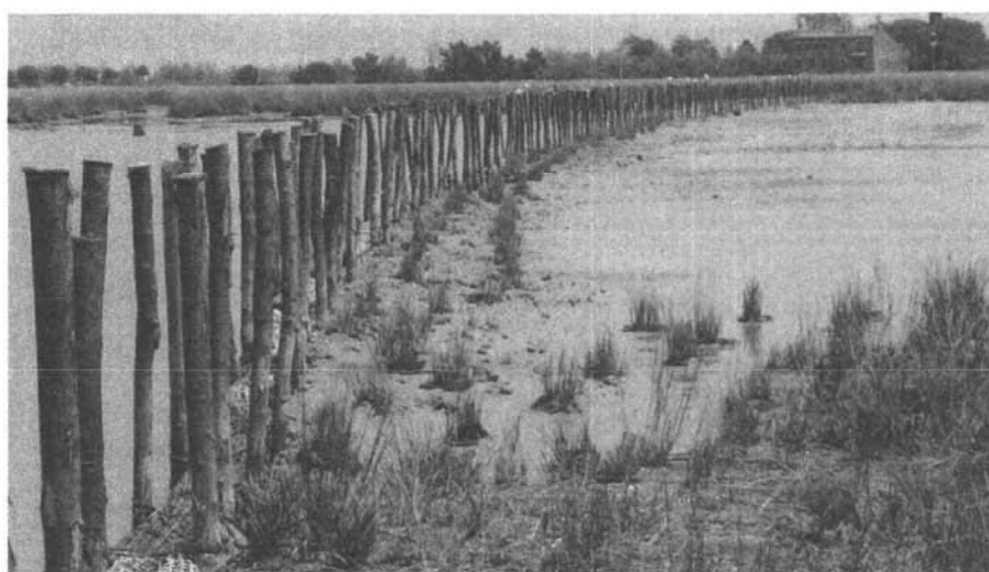
Protezione barene mediante fascinate
