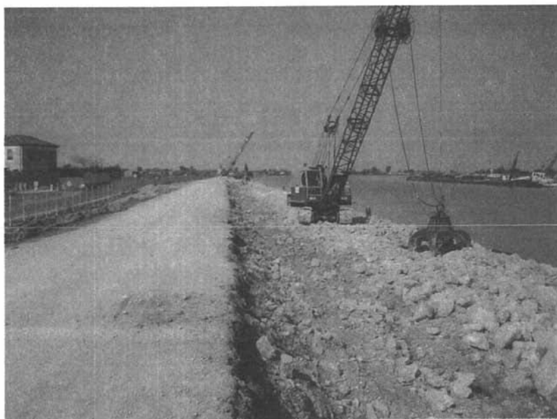
Particolare della posa di pietrame per il ringrosso a protezione dell'argine e della strada
