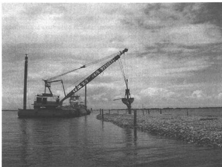
Fase di realizzazione della soffolta
