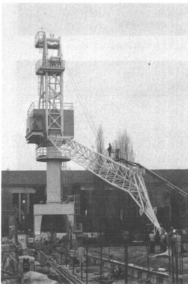
In queste foto: sopra vista del bacino durante i lavori di restauro del paramento murario con la nuova gru a servizio della sponda destra; a lato, installazione della nuova gru sempre della sponda destra del bacino medio
