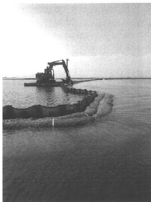
Conterminazione della barca Rivola Vecchia, pali rete e burghie
