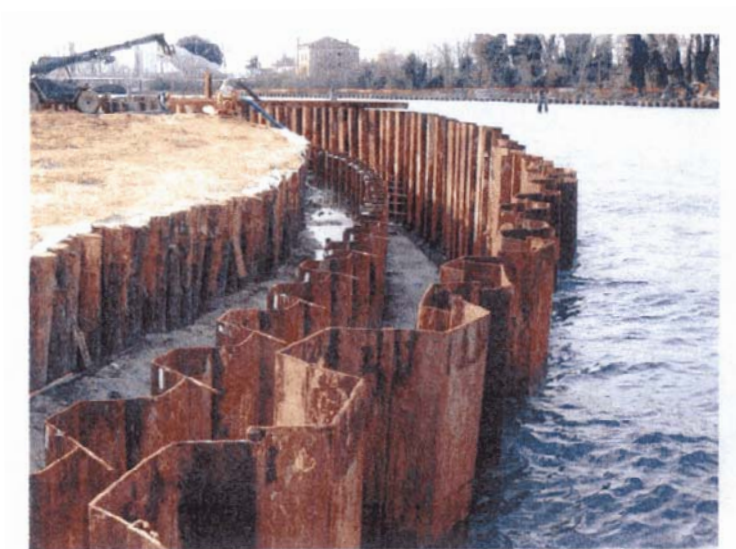
Isola delle Statue: pista perimetrale, palancolato strutturale e palancole provvisionali (sponda ovest)
