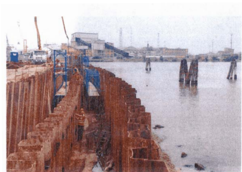
Canale Industriale Ovest sponda est: palancolato strutturale infisso all'interno delle ture provvisionali
