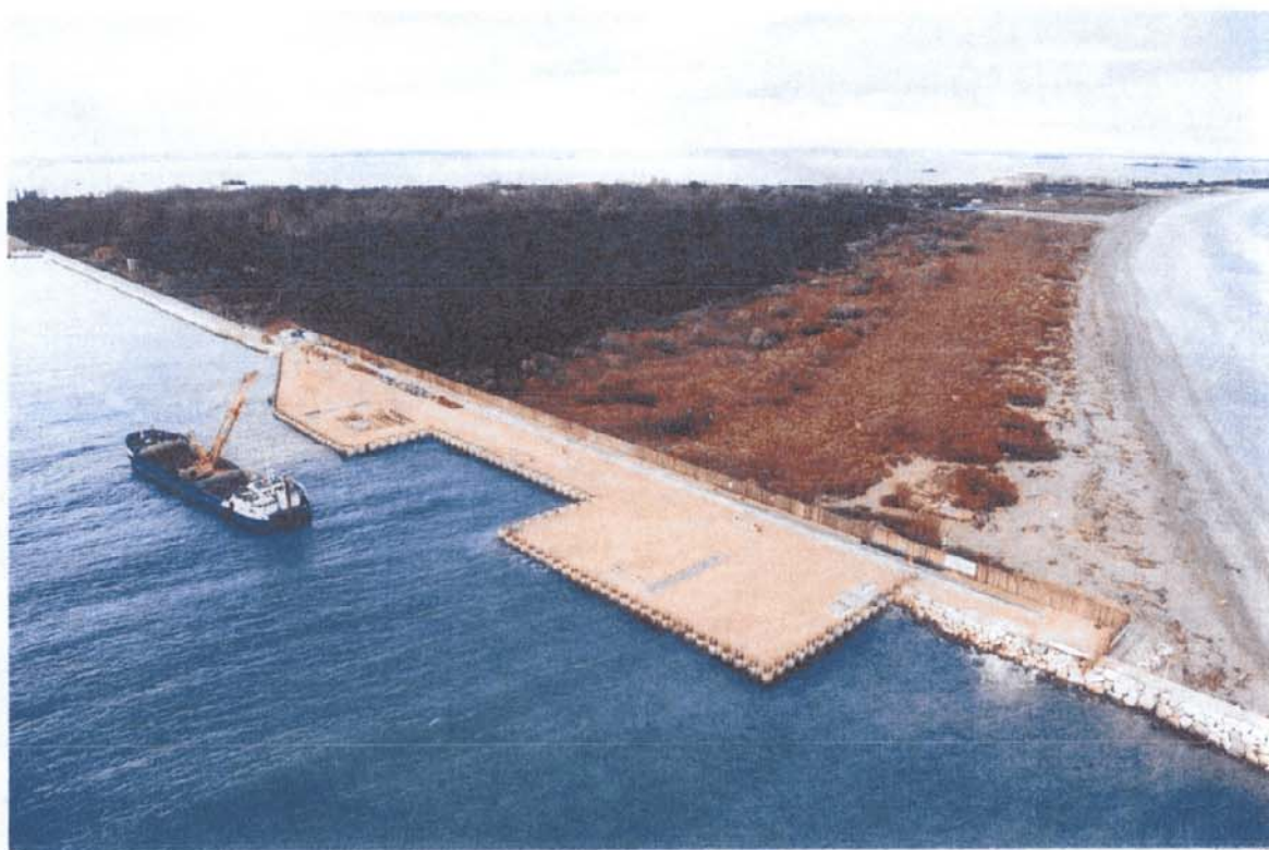
Bocca di Malamocco: particolare del lato Alberoni con il palancoato in corrispondenza della spalla nord
