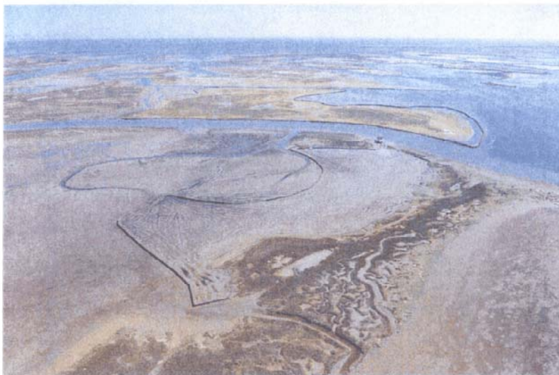
In questa foto, sono in fase di realizzazione le conterminazioni delle barene mediante l'infissione di pali in legno, seguendo delle specifiche sezioni, mediante mezzi meccanici
