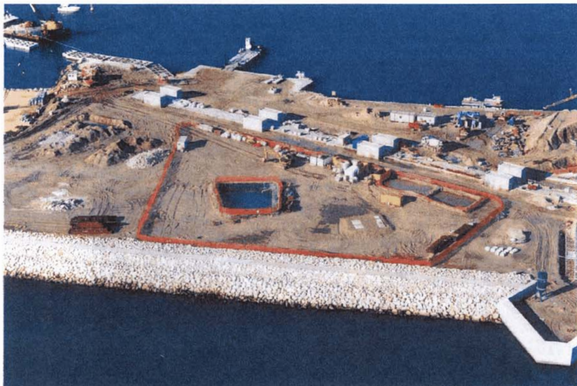
Bocca di Lido : sull'isola nuova, in primo piano il cantiere per la realizzazione delle teleguide; in secondo piano il tunnel che ospita alcune opere elettromeccaniche per il funzionamento delle paratoie
