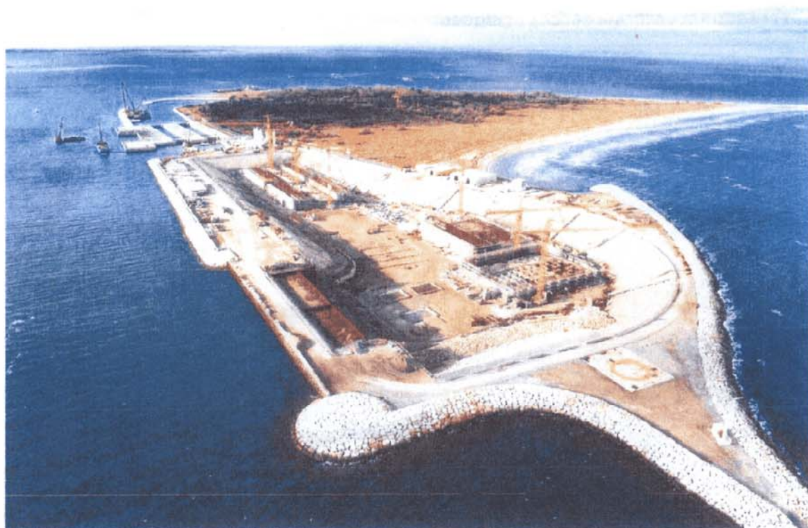
Bocca di Chioggia : in primo piano il porto rifugio lato mare messo all'asciutto per essere utilizzato come tura per la prefabbricazione dei cassoni per la bocca di Chioggia; in alto le due conche di navigazione
