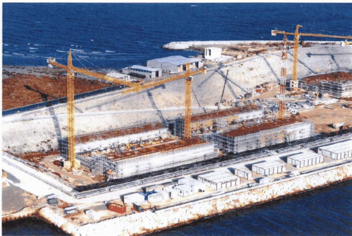
Bocca di Chioggia : particolare delle lavorazioni per la realizzazione dei cassoni di alloggiamento delle paratoie della barriera di Chioggia
