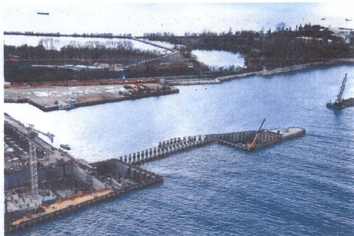
Bocca di Malamocco: particolare delle lavorazioni di infissione del palancoato che formerà la spalla sud di Malamocco
