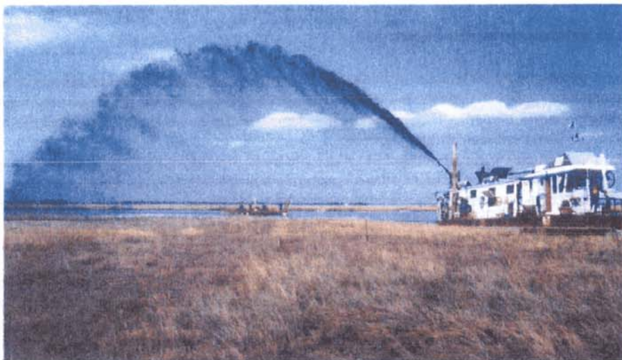
Protezione barene mediante rinascimento
