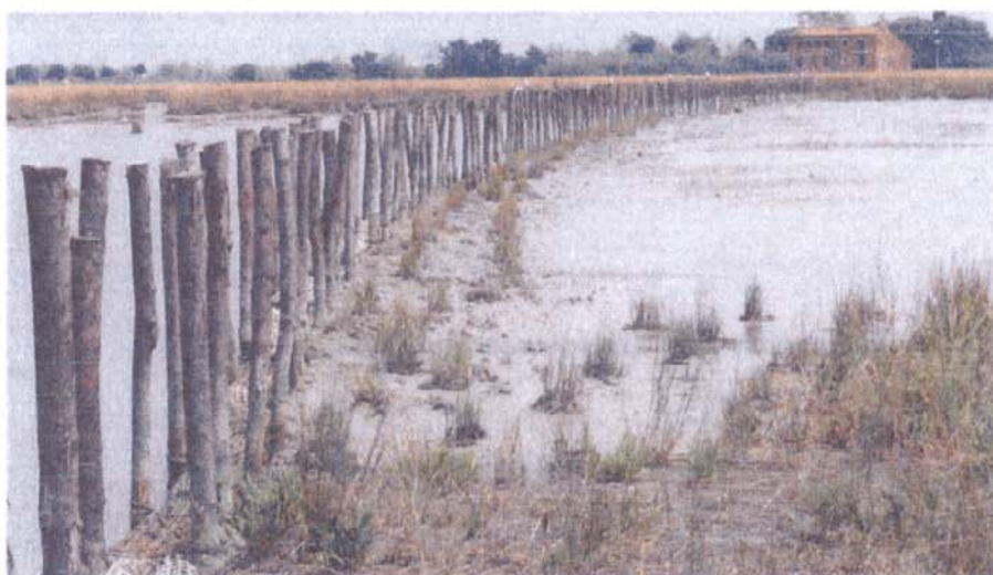
Protezione barene mediante fascinate
