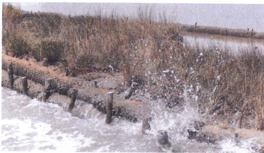
Protezione barene mediante buzzoni
