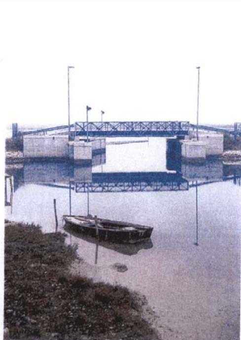
Di lato paratoie a "porte vinciane" per la protezione del territorio delle Mesole
