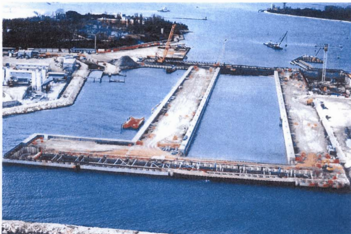
Bocca di Malamocco: veduta di dettaglio della conca di navigazione per grandi navi in avanzata fase di realizzazione
