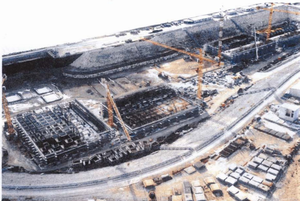
Bocca di Chioggia : il bacino del porto rifugio lato mare. Il bacino è stato messo all'asciutto e utilizzato come "tira" per la prefabbricazione dei cassoni di alloggiamento delle paratoie della barriera di Chioggia
