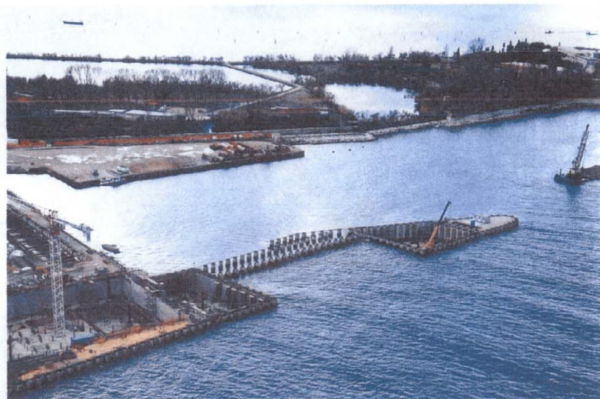
Bocca di Malamocco: particolare delle lavorazioni di infissione del palancolato che formerà la spalla sud di Malamocco
