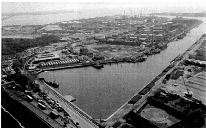
Canale Industriale Brentella vista aerea della darsena a lavori ultimati
