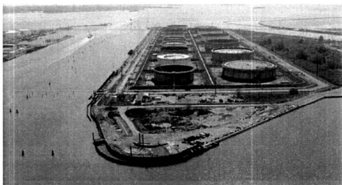
Isola del Serbatol sponda ovest: marginamento in fase di ultimazione lato bacino di evoluzione n. 1
