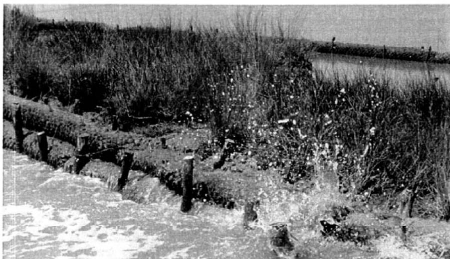
Protezione barene mediante buzzoni
