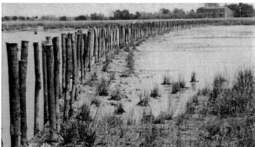
Protezione barene mediante fascinate
