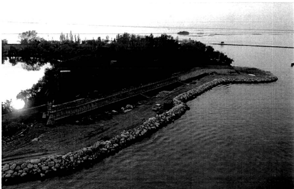
Bocca di Malamocco: vista generale dell'area delle attività per la protezione della sponda del Forte S. Pietro. Si notano in particolare le impalcature per il restauro delle vecchie murature del forte
