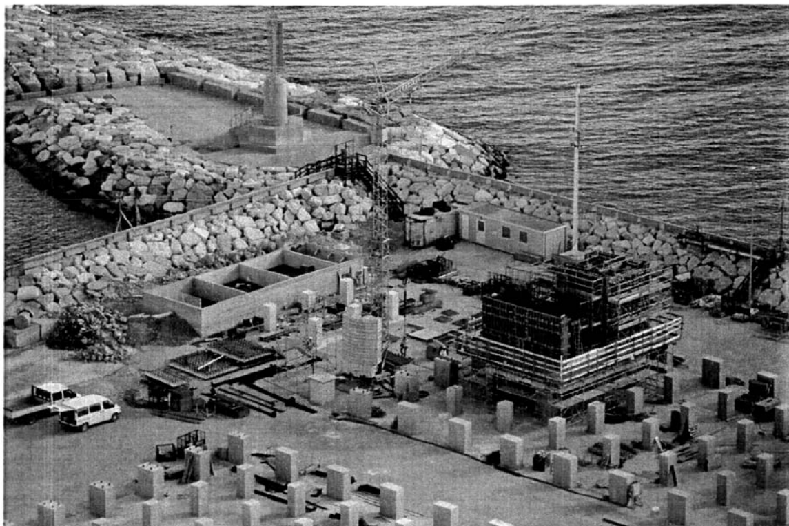
Bocca di Malamocco: particolare delle lavorazioni di realizzazione del mock-up, il modulo in scala 1:1 sul quale verranno eseguite alcune prove per ottimizzare la successiva esecuzione dei cassoni
