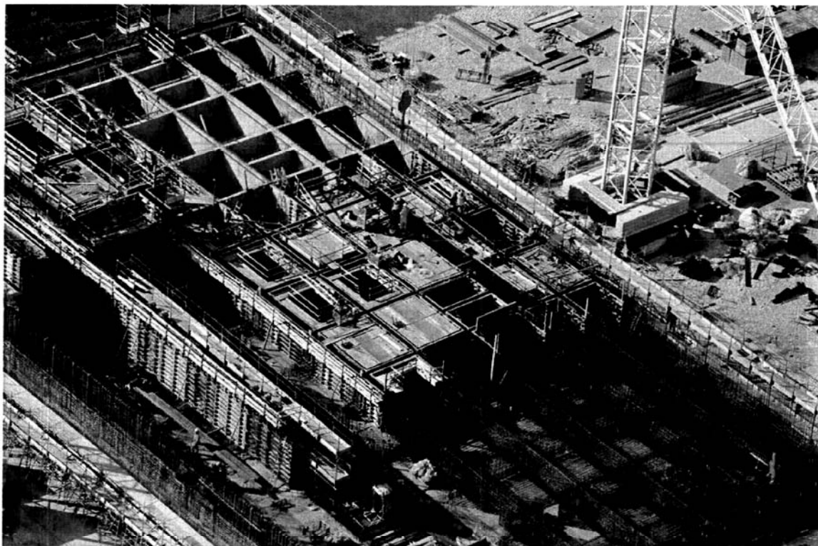
Bocca di Lido - Treporti: particolare delle attività di realizzazione del primo cassone della barriera di Treporti
