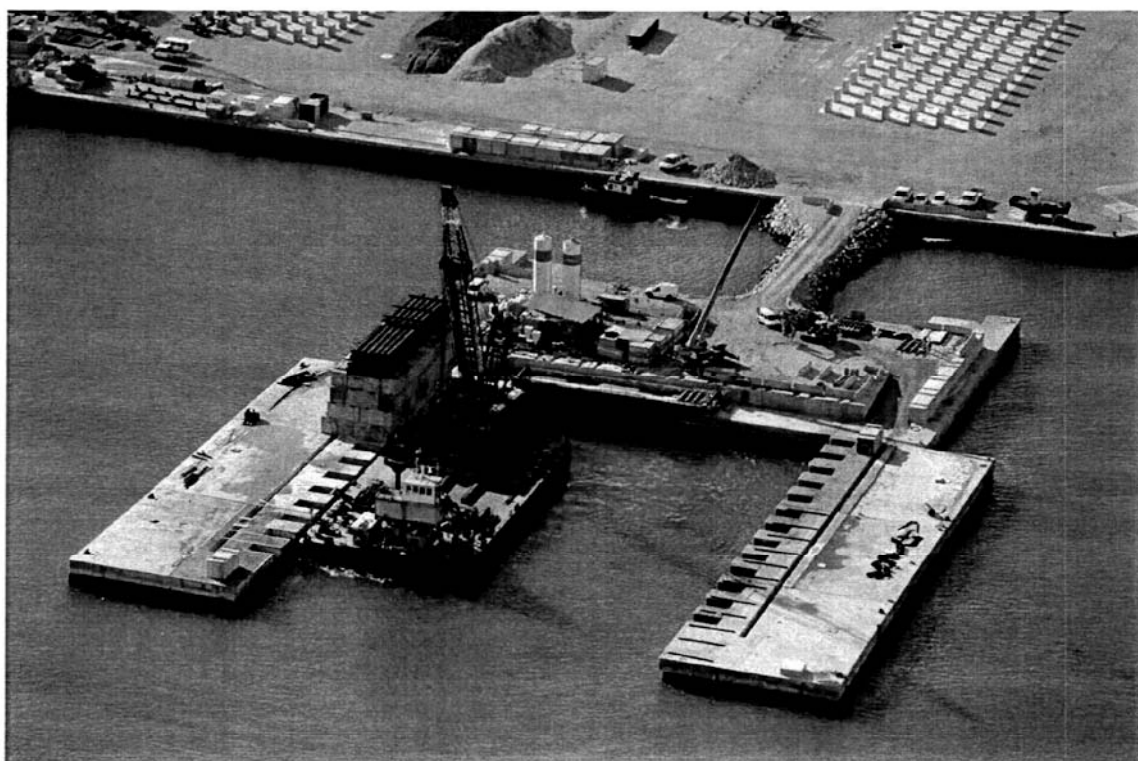
Bocca di Malamocco: in primo piano la realizzazione della struttura su cui poggierà il sistema Syncrolift per il varo dei cassoni
