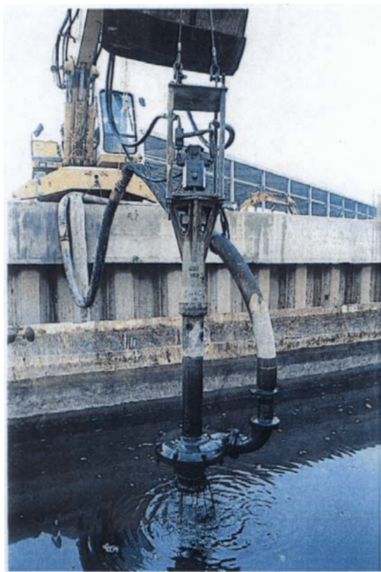
In questa pagina: alcune fasi dei lavori, il materiale viene selezionato attraverso appositi dispositivi "rotostacchi", situati sul pontone di appoggio, che servono per separare il fango inquinato dai solidi da smaltire come inerti (sassi, pezzi di ferro o plastica, ecc.).
