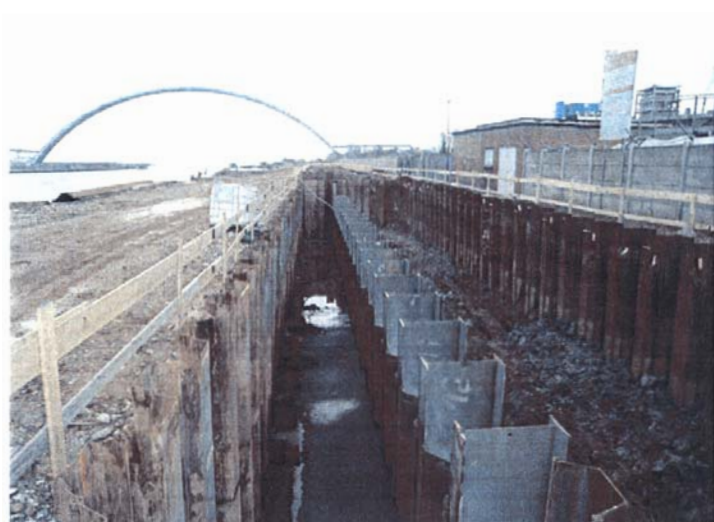
Canale Industriale sud sponda sud, sponda Fassa ex Edison. Marginamento in fase di lavorazione; palancoato strutturale infisso all'interno della tura.
