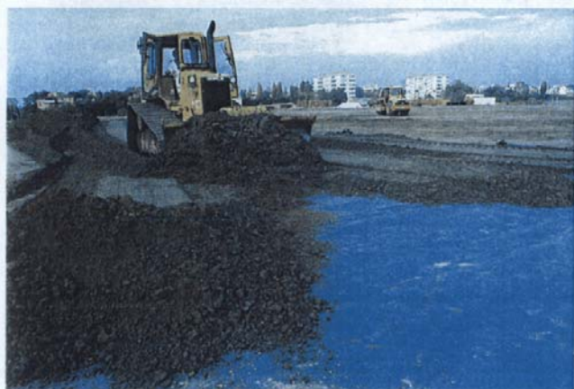
Barena del Passo a Campalto. Realizzazione del diaframma di bentonite granulare (area fosfogessi). Riempimento del cassero della benna.
