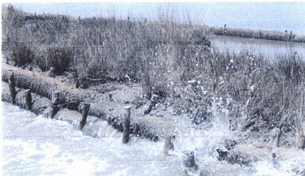
Protezione barene mediante buzzoni.
