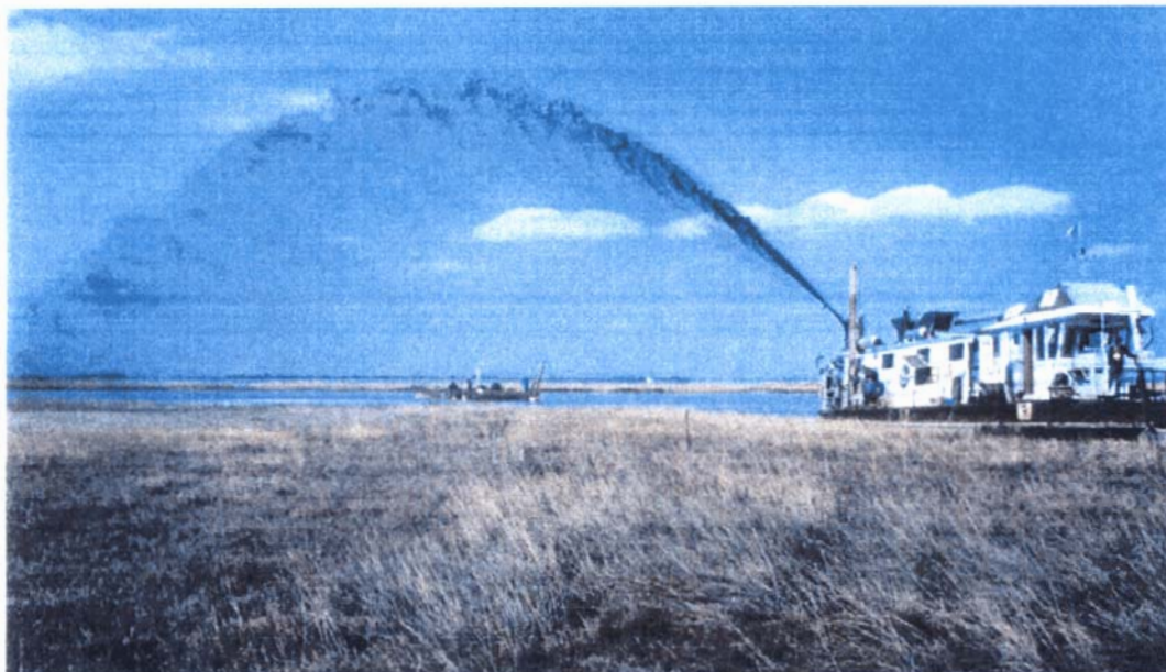
Protezione barene mediante rinascimento.
