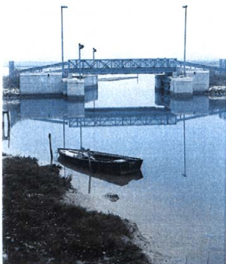
Di lato paratoie a "porte vinciane" per la protezione del territorio delle Mesole.
