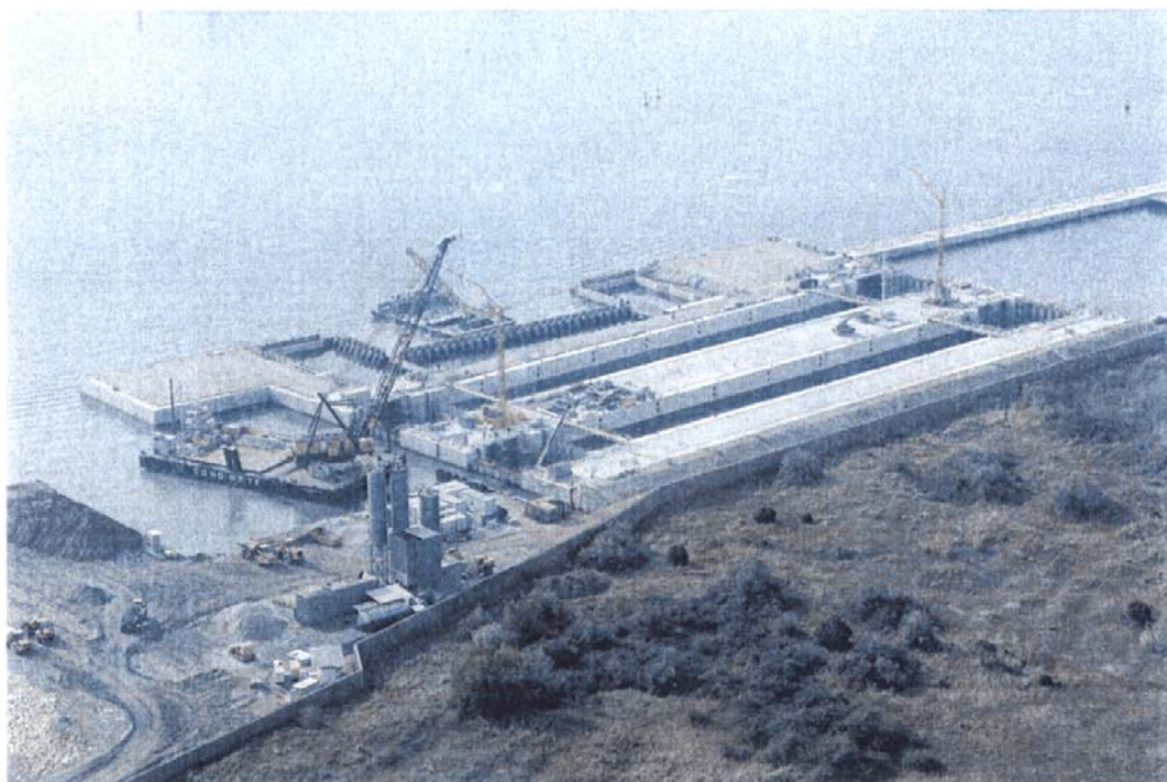
Bocca di Chioggia: veduta lato Cà Roman delle conche di navigazione (In primo piano) e delle strutture della spalla nord in via di realizzazione.
