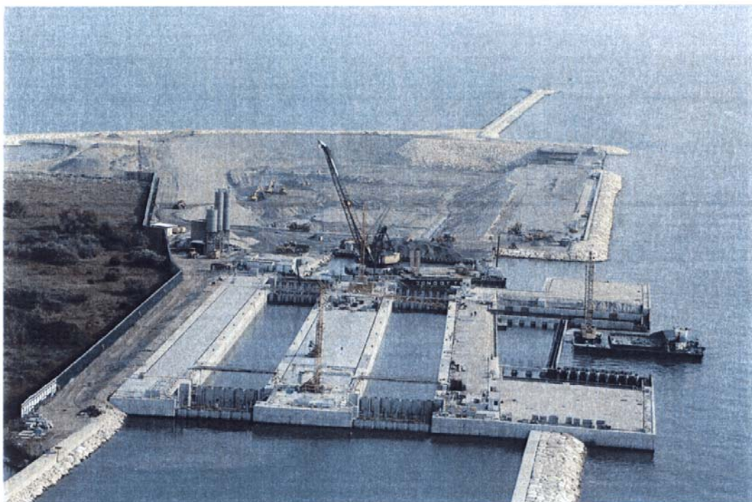
Bocca di Chioggia: veduta generale delle conche di navigazione e della spalla nord della barriera. Sullo sfondo il porto rifugio lato mare messo all'asciutto.
