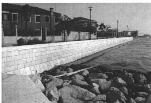
Un tratto di riva dopo i lavori.
