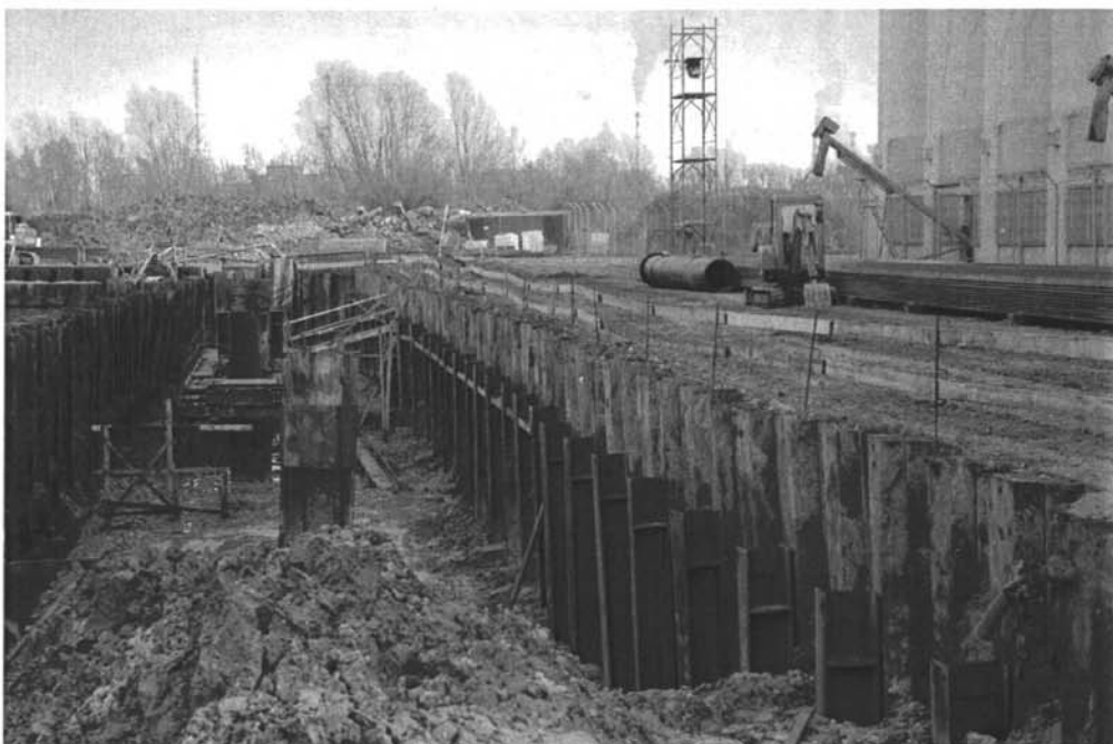
Canale industriale sud sponda sud, area Pagnan – Colacem. Tura provvisoria per la realizzazione del marginamento
