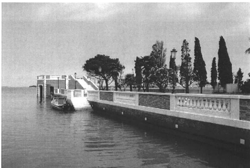
Isola degli Armeni: in alto, un tratto di sponda prima degli interventi dove sono evidenti i danni e i dissesti prodotti dall'azione delle maree e del moto ondoso. In basso, lo stesso tratto di riva a lavori ultimati.
