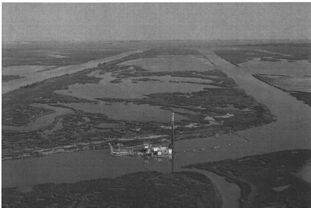
Lavori di ripristino di una barena nell'area Lago Teneri.
