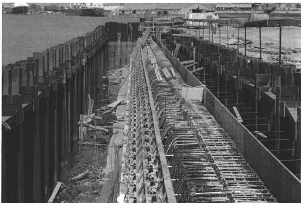
Fase di realizzazione del cordolo sommitale
