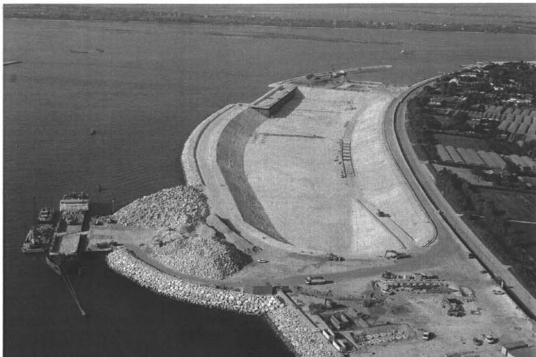
Bocca di Lido - Treporti : particolare del bacino del porto rifugio lato mare messo all'asciutto. Sono in costruzione le strutture delle piastre per la prefabbricazione dei cassoni. Nella parte alta della foto, il "cofferdam" che verrà demolito per far uscire i cassoni in galleggiamento una volta realizzati.
