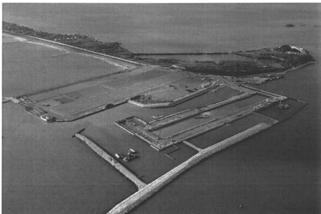
Bocca di Malamocco : da destra verso sinistra: la parete combinata collegata al molo sud che costituisce la spalla sud della barriera; la conca di navigazione per grandi navi; il cantiere provvisorio su rilevato per la prefabbricazione dei cassoni di alloggiamento delle paratoie della barriera di Malamocco; sullo sfondo il litorale di Pellestrina.
