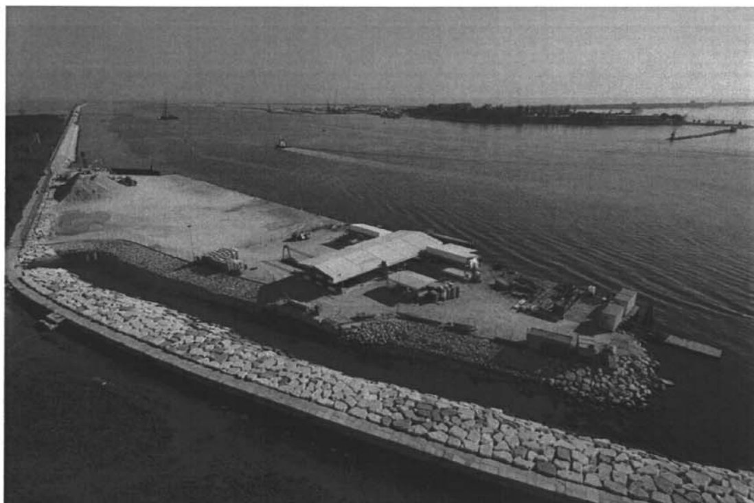
Bocca di Malamocco : in primo piano la piarda provvisoria sopra il quale è stato realizzato l'impianto di prefabbricazione dei materassini zavorrati per la protezione dei fondali della bocca.
