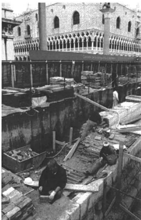
Difesa Insula di San Marco. Vista del molo durante i lavori.
