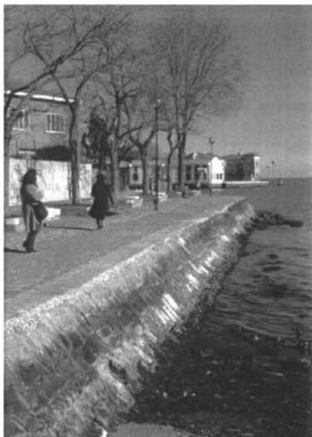
Un tratto di riva prima dei lavori.
