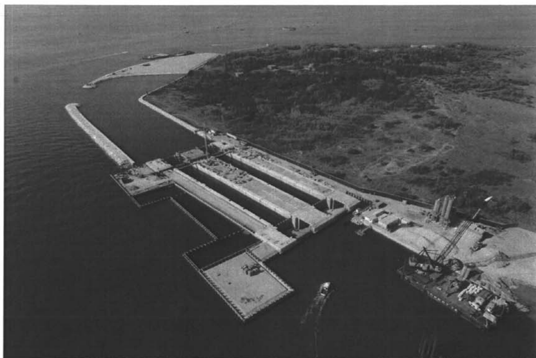
Bocca di Chioggia : le due conche di navigazione per pescherecci, con le opere civili delle camere e degli alloggiamenti delle porte già completate. In primo piano, la parete combinata che delimita le strutture della spalla nord.
