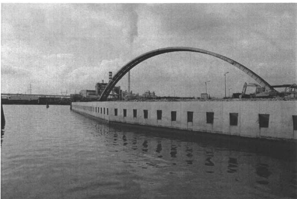
Marginamento in fase di ultimazione nel tratto della sponda della penisola del nuovo petrochimico in prossimità del bacino di evoluzione n. 4
