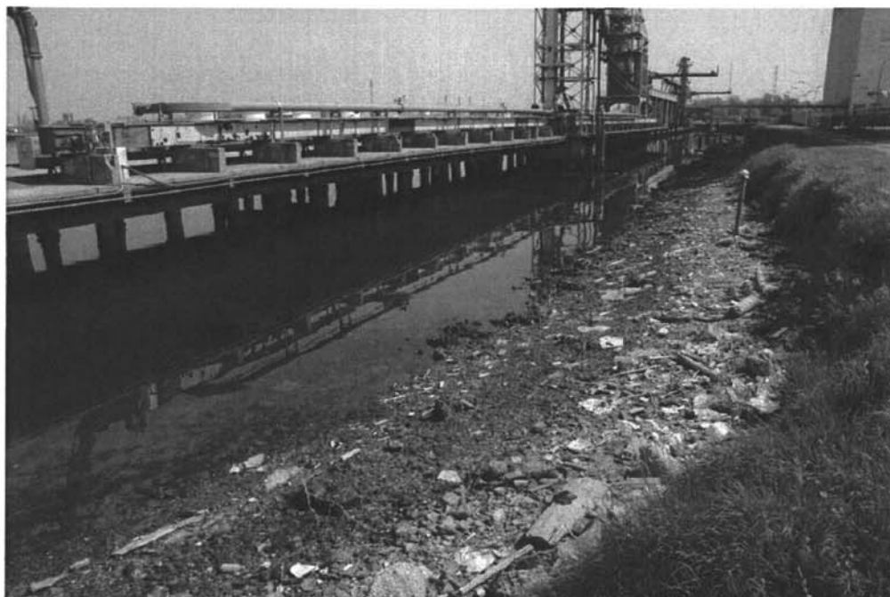
Canale industriale sud sponda sud, area Pagnan – Colacem. Stato di fatto di un tratto di marginamento
