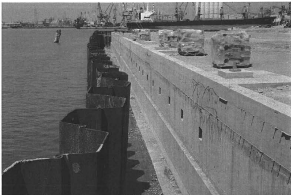
Tratto di marginamento in fase di ultimazione lungo la sponda sud
