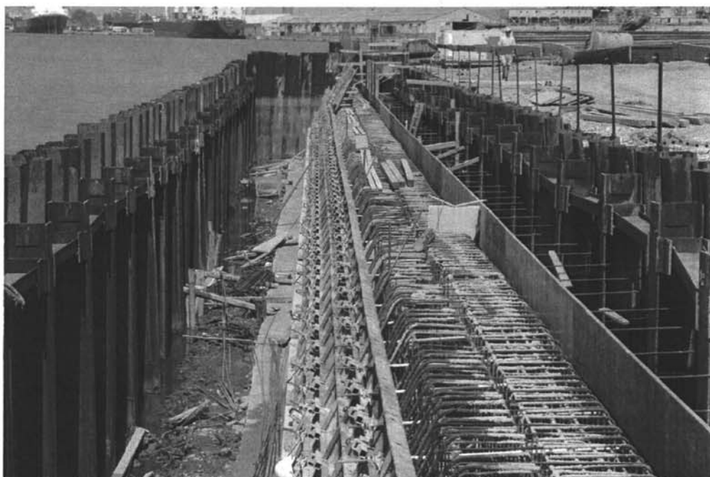
Fase di realizzazione del cordolo sommitale
