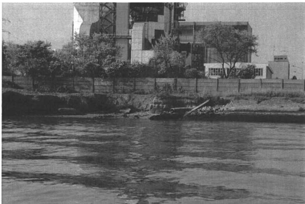
Canale industriale sud sponda sud, area Fassa ex Edison. Stato di fatto di un tratto di marginamento
