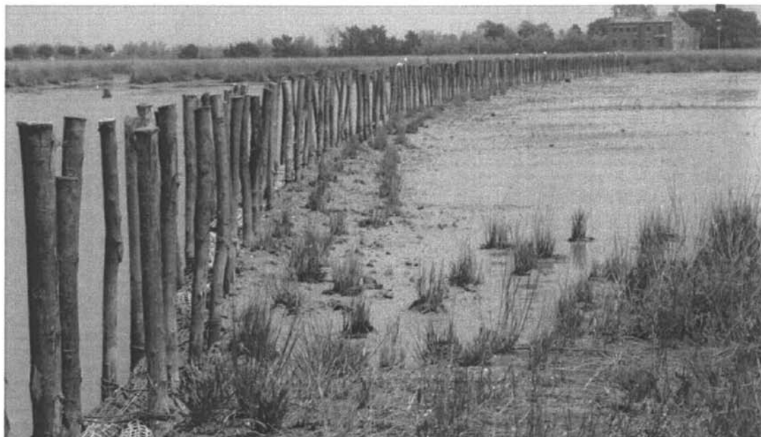
Protezione barene mediante fascinate.
