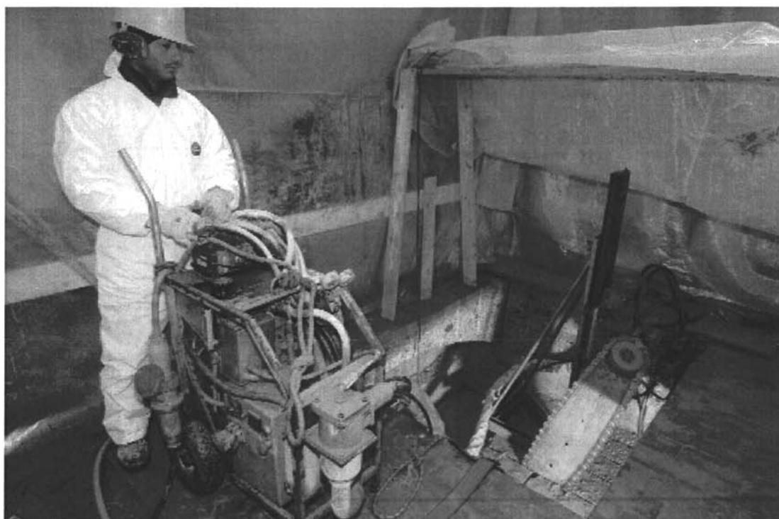
Indagini strutturali e statiche all'interno della loggetta. Nell'ambito di queste attività è stato possibile realizzare anche alcune lavorazioni preliminari all'avvio degli interventi.
