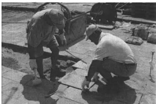
Difesa rive bacino S. Marco tra Ponte della Paglie e Ponte del Vin. Un tratto della riva durante i lavori.
