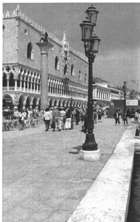
Difesa Insula di San Marco Vista del molo a lavori ultimati.
