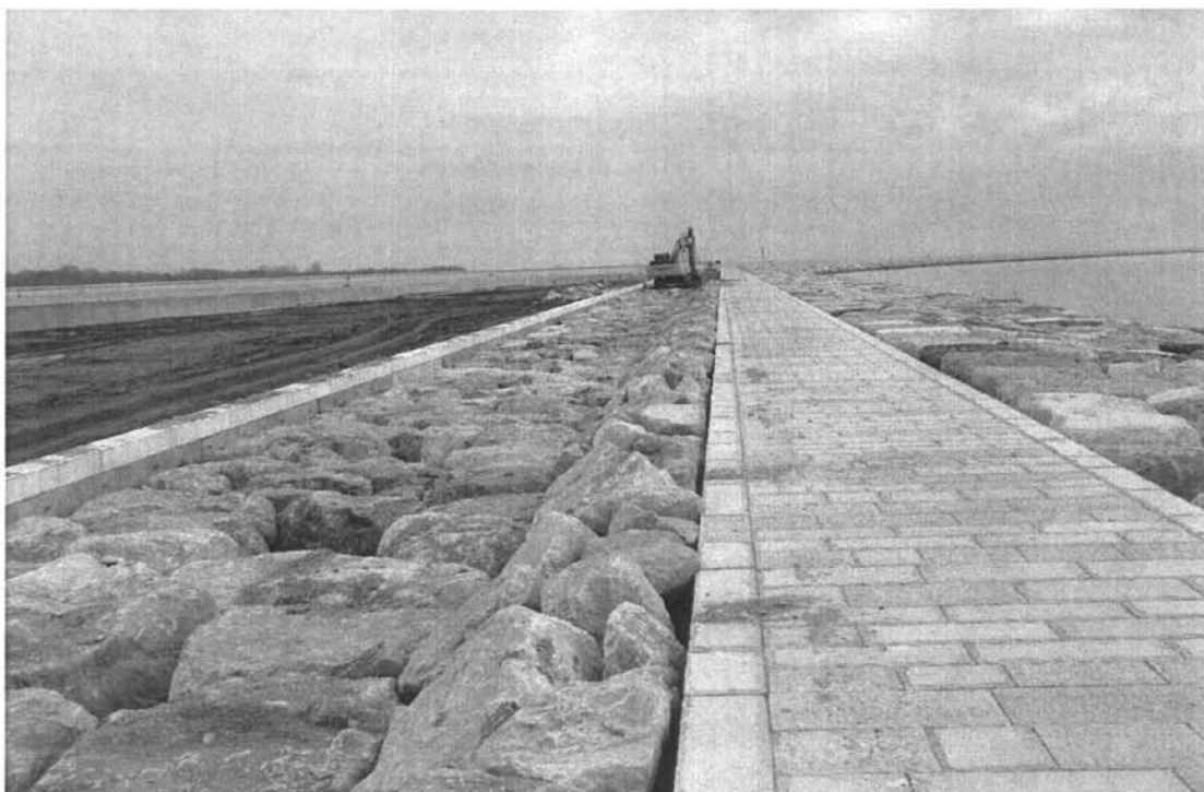
Bocca di Lido - S. Nicolò: particolare della pavimentazione e della scogliera realizzata nell'ambito del rinforzo della radice del molo sud.
