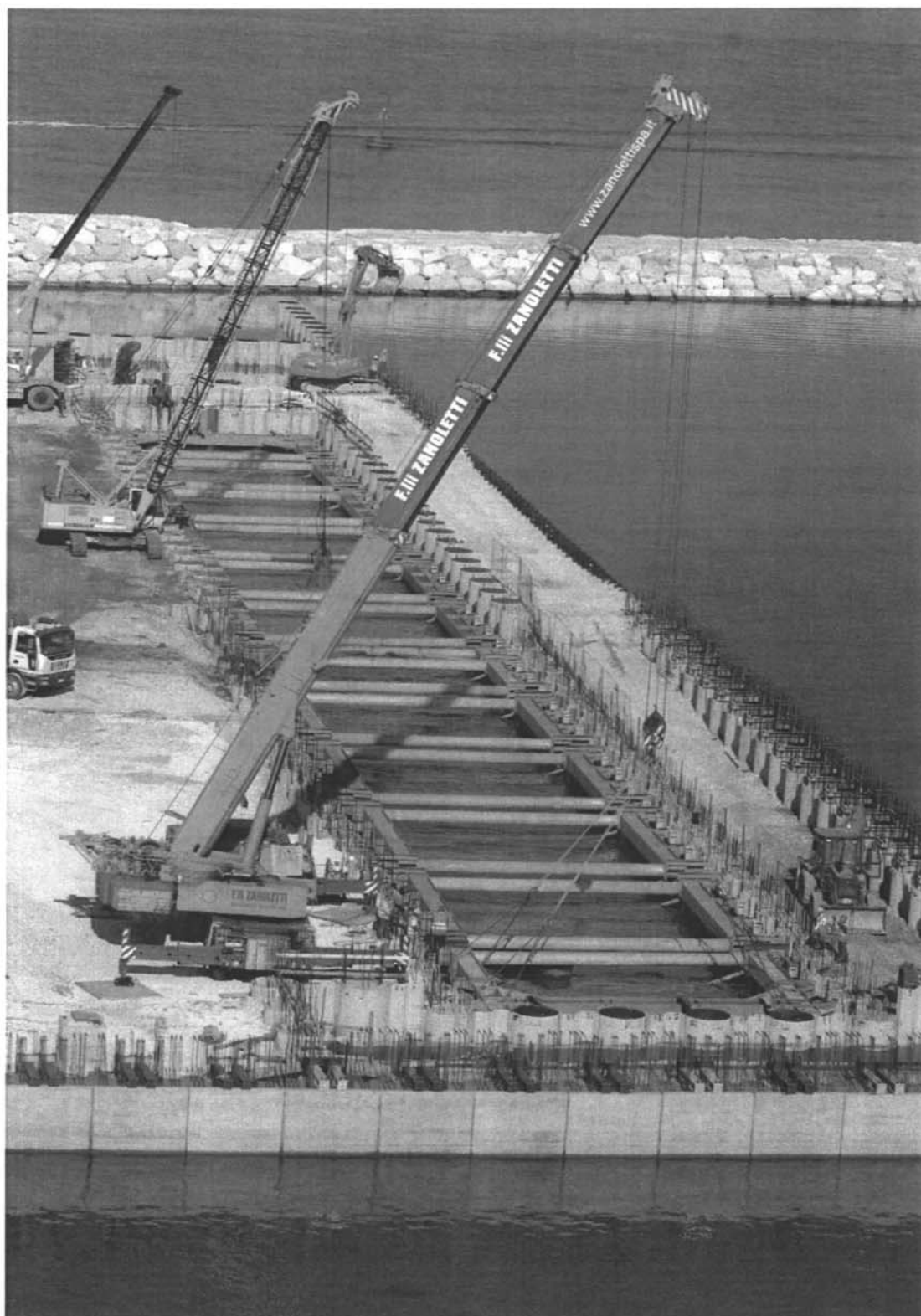
Bocca di Malamocco: particolare della struttura di alloggiamento della porta della conca lato mare.
