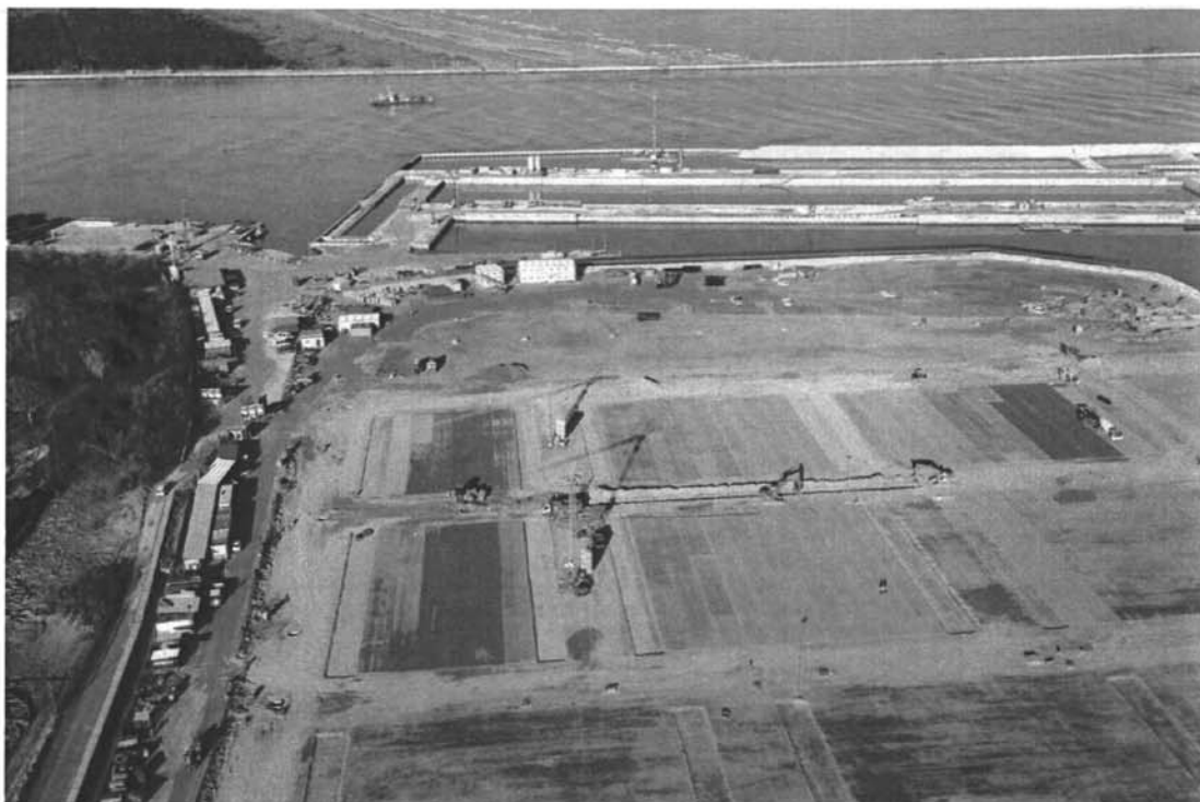
Bocca di Malamocco : Infrastrutture per la prefabbricazione dei cassoni, realizzazione delle piastre sul rilevato.
