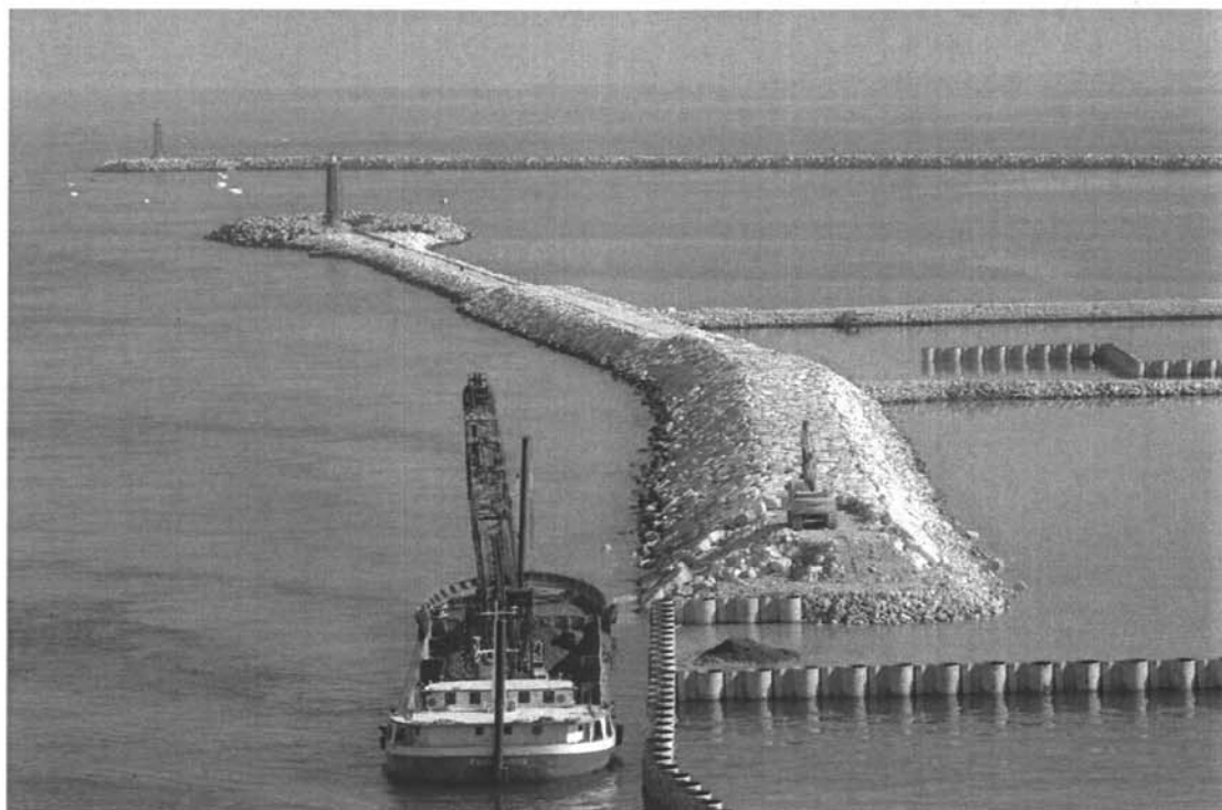
Bocca di Malamocco : particolare del molo sud rinforzato e della parete combinata che costituisce la spalla sud della barriera. Sullo sfondo la diga foranea già completata.
