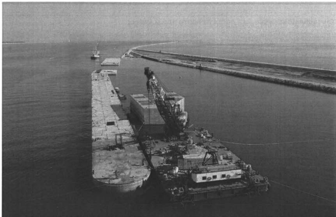
Bocca di Lido - S. Nicolò: i cassoni prefabbricati in calcestruzzo armato che costituiscono la struttura della spalla sud della barriera di S. Nicolò, già posizionati e zavorrati.
