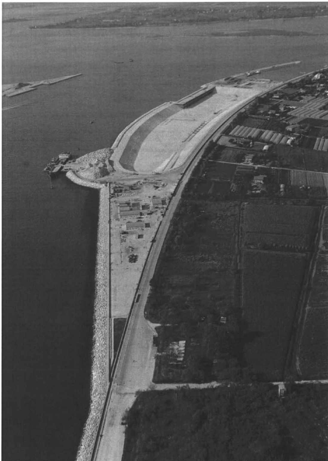
Bocca di Lido - Treporti : il porto rifugio lato mare, il cui bacino messo all'asciutto viene utilizzato come "tura" per la costruzione dei cassoni di alloggiamento delle paratoie della barriera di Treporti. Si nota il cantiere per la prefabbricazione.
