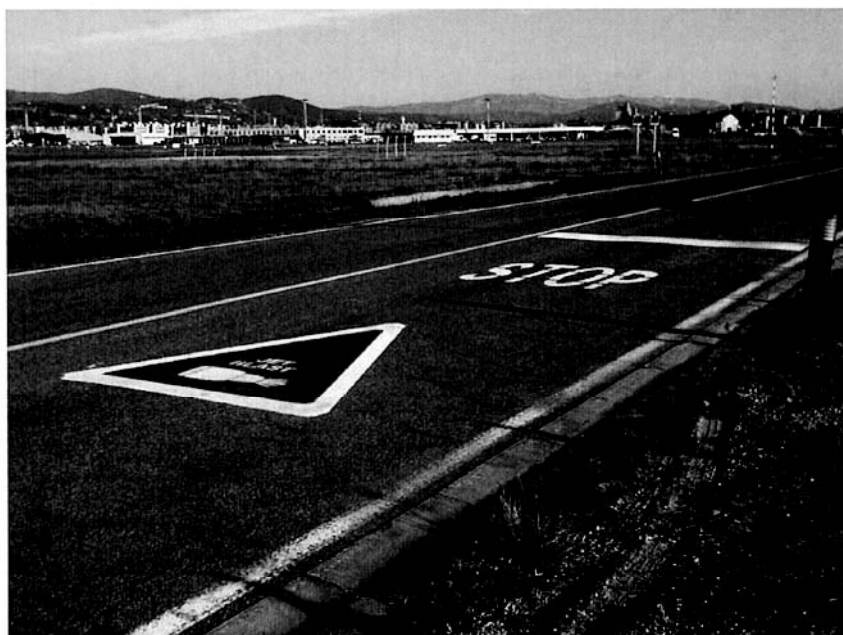
Segnaletica orizzontale apposta sulla strada perimetrale dopo l'evento del 21.1.2011 per richiamare l'attenzione sul rischio del jet blast .
