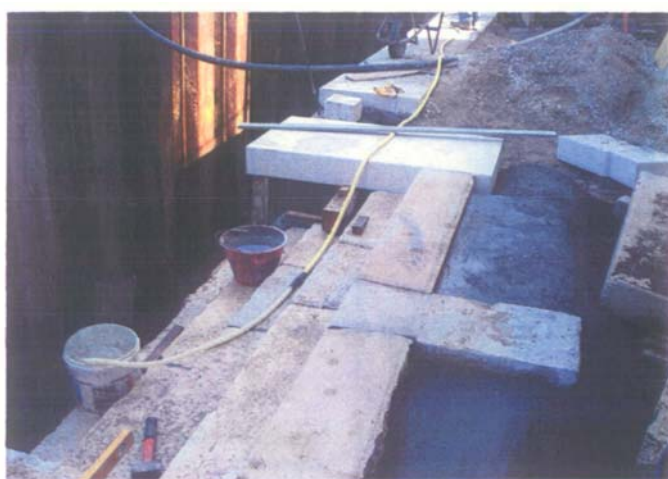
Ripristino delle scale esistenti sul marginamento
