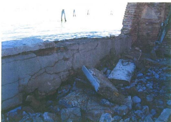
Demolizioni nell'area d'intervento di S. Alvise
