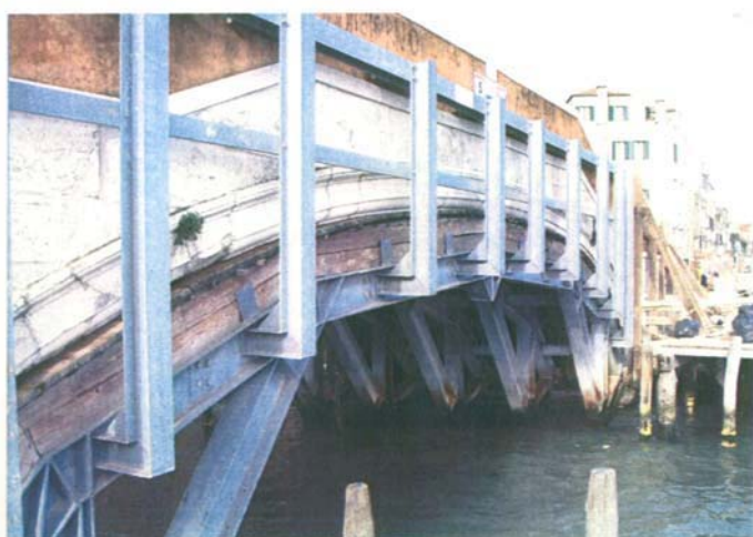
Centinatura di Ponte Donà prima degli interventi progettuali
