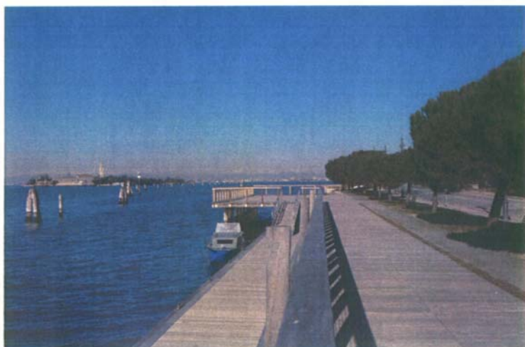
Un tratto di riva a lavori ultimati
