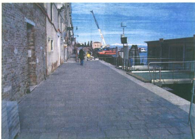
Area d'intervento a lavori ultimati nei pressi di Ponte Donà dopo il rialzo del marginamento e della pavimentazione
