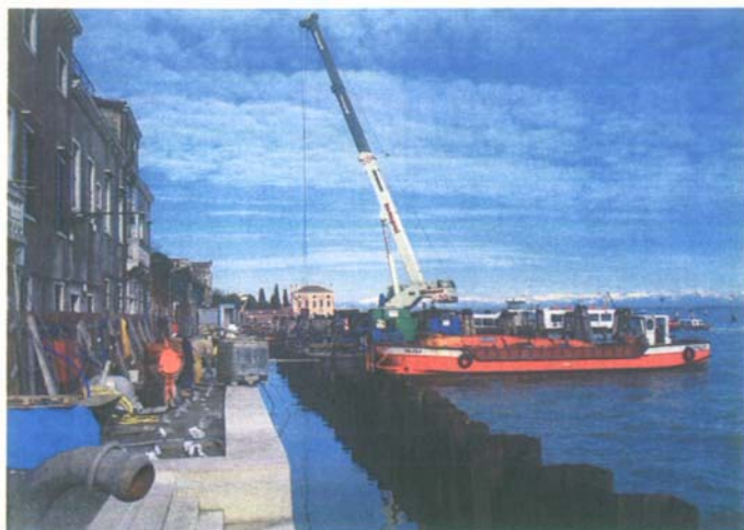
Rimozione del palancolato provvisorio dopo l'ultimazione dei lavori di marginamento nell'area d'intervento di primo stralcio
