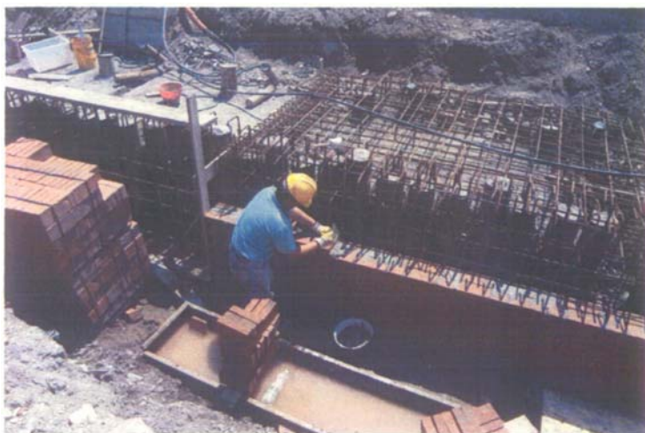
Una fase dei lavori
