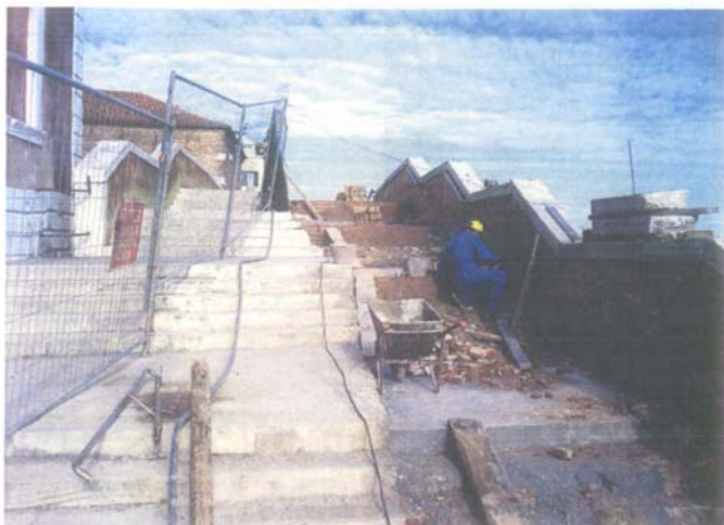
Ripristino dei paramenti murari delle spalle di Ponte Donà
