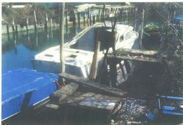
Un tratto di riva sul rio Strocca prima dei lavori
