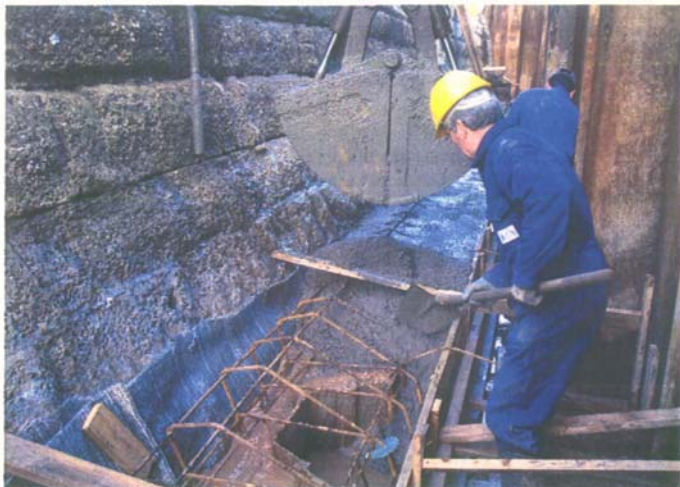
Esecuzione di cordolo in cemento armato sulla sommità della palancole antiscalzamento
