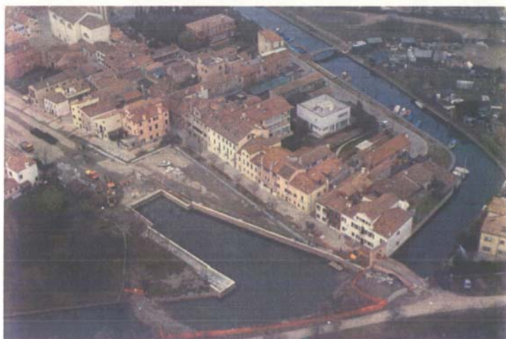
Vista aerea della zona tra rio Strocca e rio Squero durante i lavori di ristrutturazione delle rive e di riapertura dello spazio acqueo
