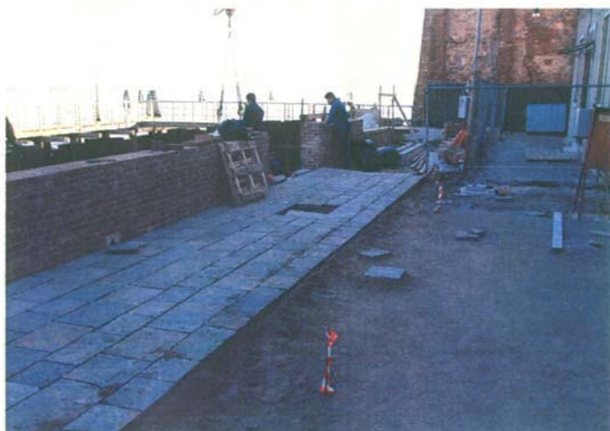
Rifacimento del parapetto in muratura sul marginamento e rifacimento della pavimentazione del campietto S. Alvise
