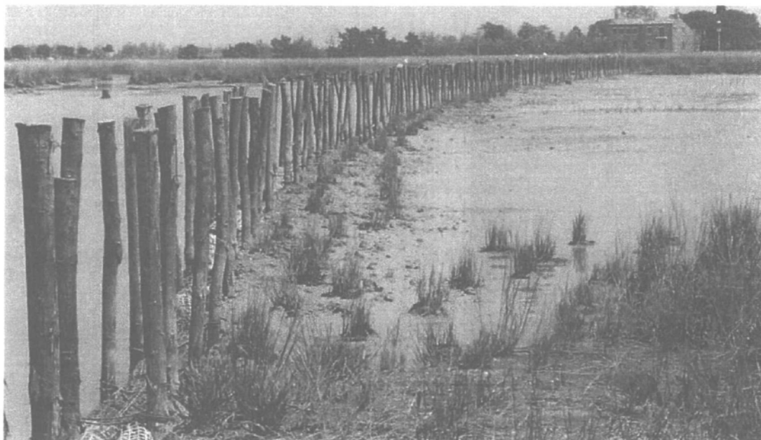
Protezione barene mediante fascinate.
