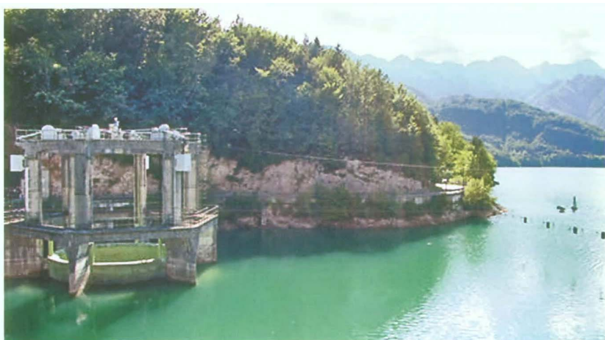
Barcis (Pordenone) • Diga del Lago di Barcis
