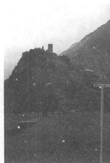
Italia, Val d'Aosta. Ripristino ambientale sul tracciato del gasdotto.
