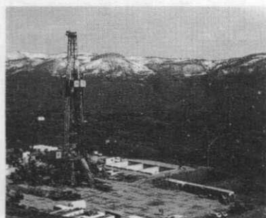
Italia, Val d'Agri. Pozzo di perforazione.
