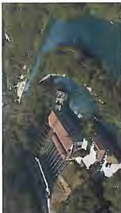
La storica centrale idroelettrica "Bertini", in esercizio dal 1898
