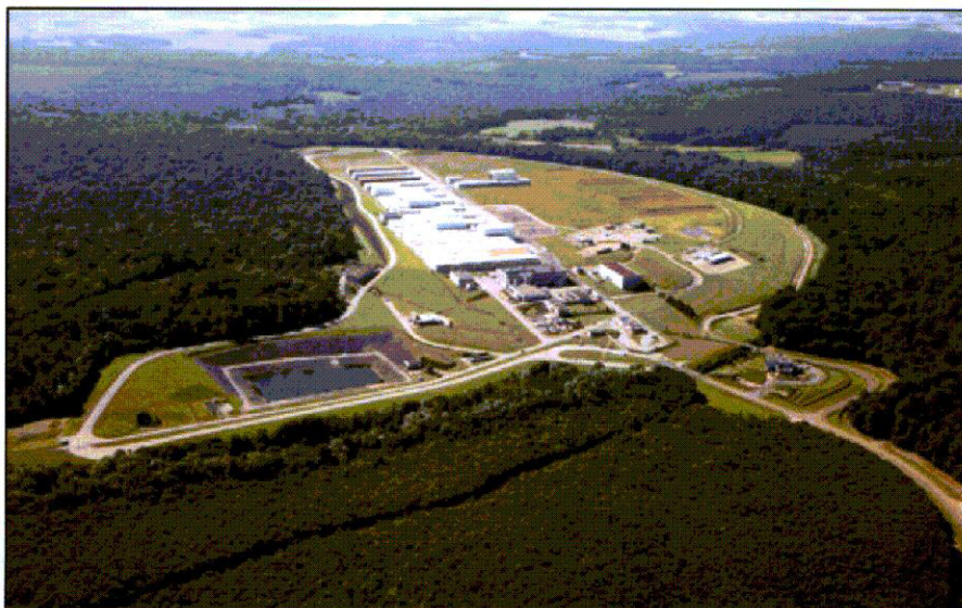
Figura 4 – Vista d'insieme del deposito per rifiuti a bassa e media attività de l'Aube.
