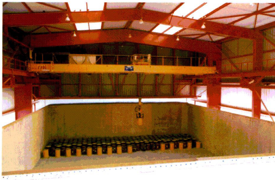
Figura 5 – Caricamento di una cella nel deposito de l'Aube.
